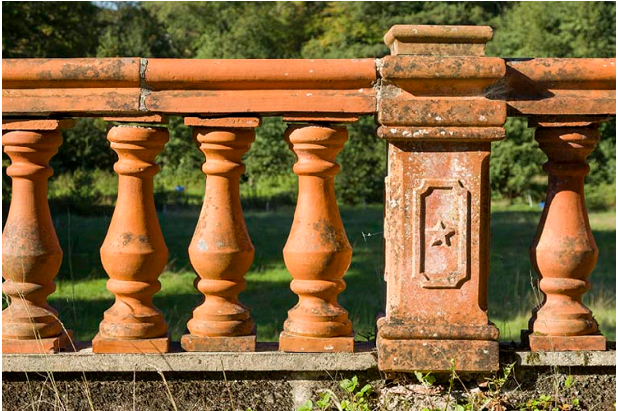
Balustrade de la terrasse, façade nord.
