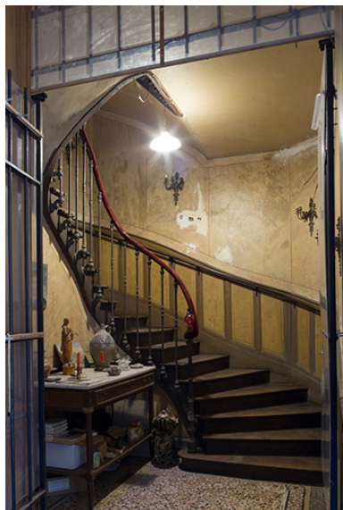
L'escalier intérieur. Phot. Sonia Dourlot IVR43_20157000699NUC2A
