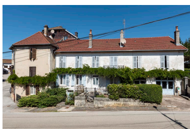
Bâtiment au 8 Grande Rue. Phot. Sonia Dourlot
