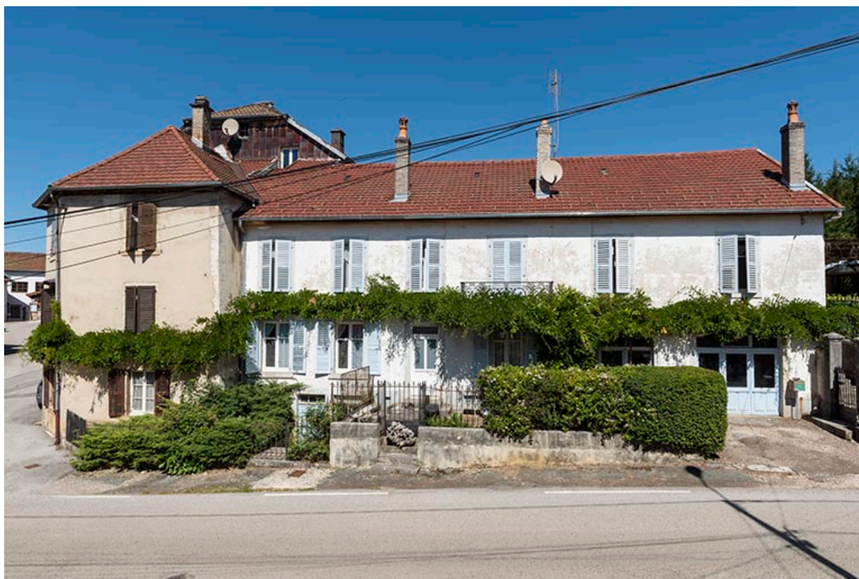
Bâtiment au 8 Grande Rue.
