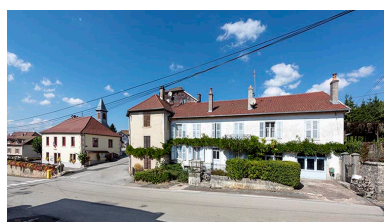
Vue d'ensemble sur la Grande Rue. Phot. Sonia Dourlot IVR43_20192501236NUC4A
