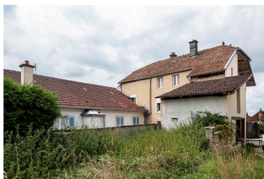
Bâtiment au 2 rue du Chêne : façade postérieure.
