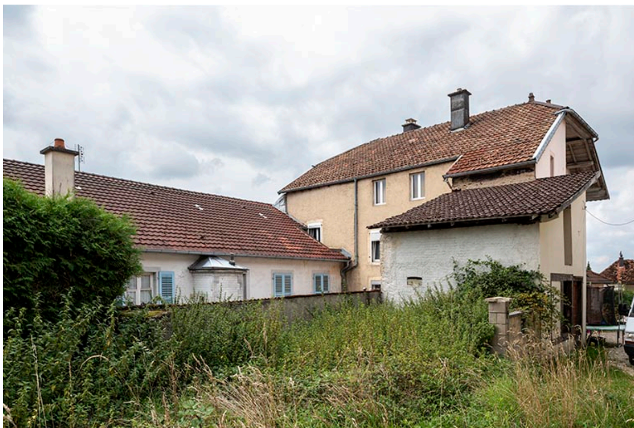
Bâtiment au 2 rue du Chêne : façade postérieure.
