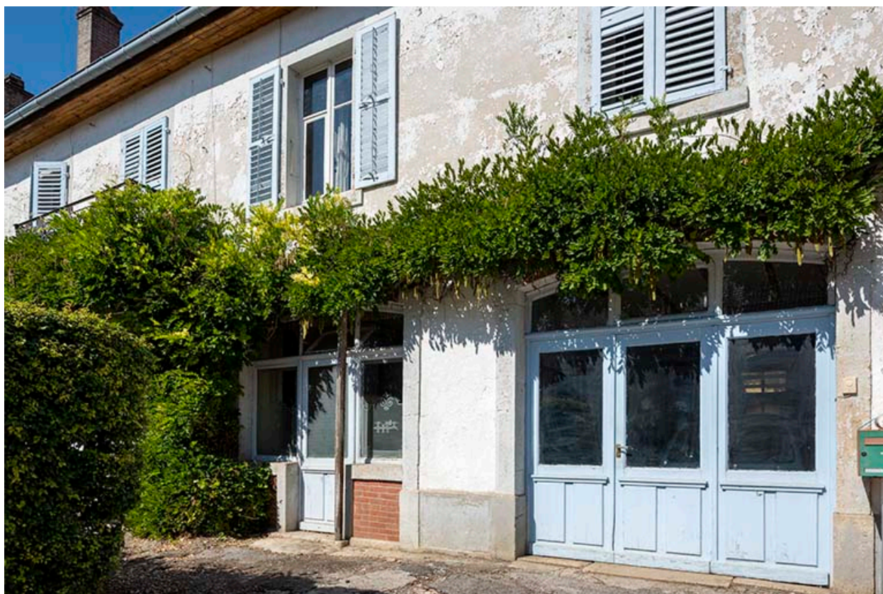
Bâtiment au 8 Grande Rue : portes du magasin.
