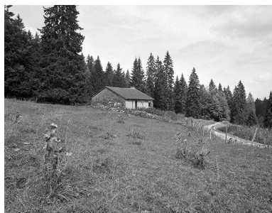
Vue de situation. Phot. Jérôme Mongreville IVR43_20003900513X
