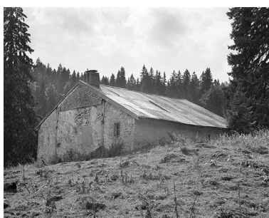
Face droite vue de trois quarts. Phot. Jérôme Mongreville IVR43_20003900511X
