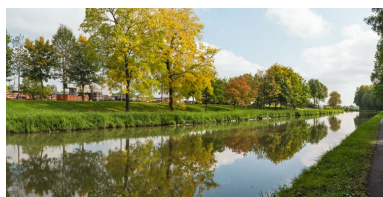
Vue d'ensemble de la scierie et du canal. Phot. Pierre-Marie Barbe-Richaud IVR26_20177100451NUC2AQ
