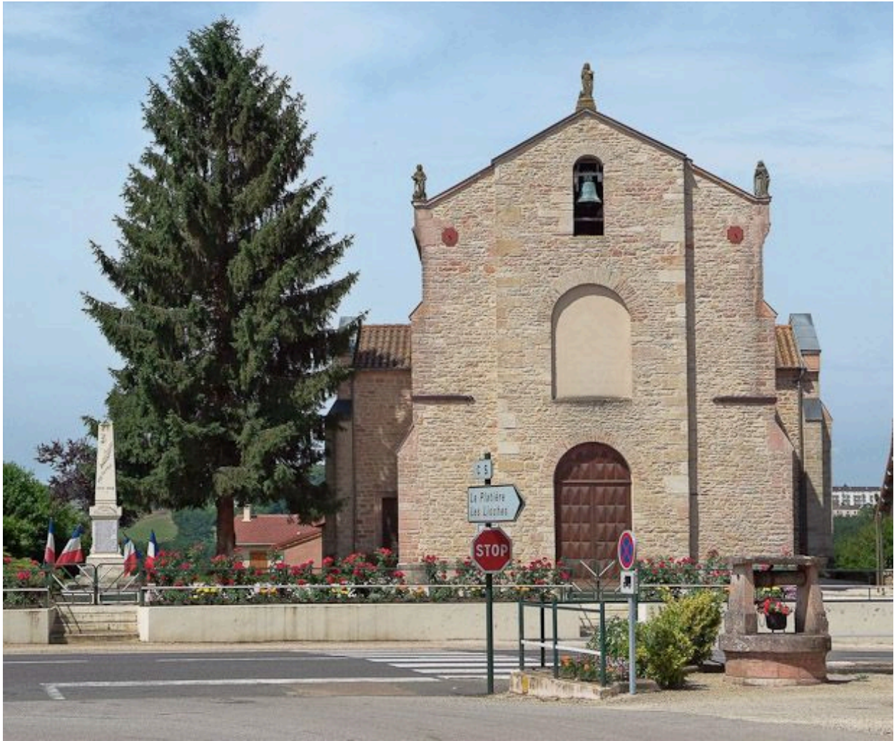
Vue d'ensemble de la façade.
