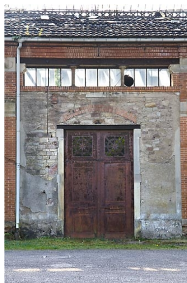
Façade antérieure. Détail d'une travée. Phot. Jérôme Mongreville IVR43_20077000613NUCA
