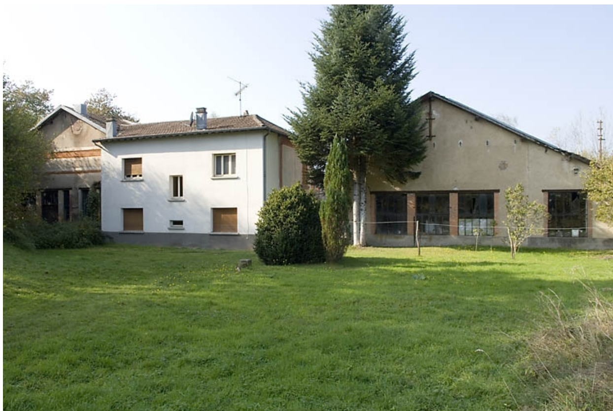
Façades postérieures depuis l'est.
