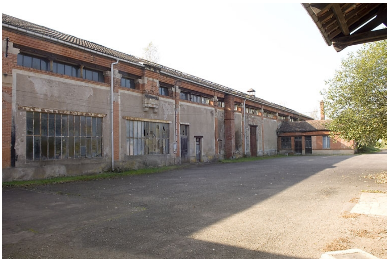
Façade antérieure depuis l'est.
