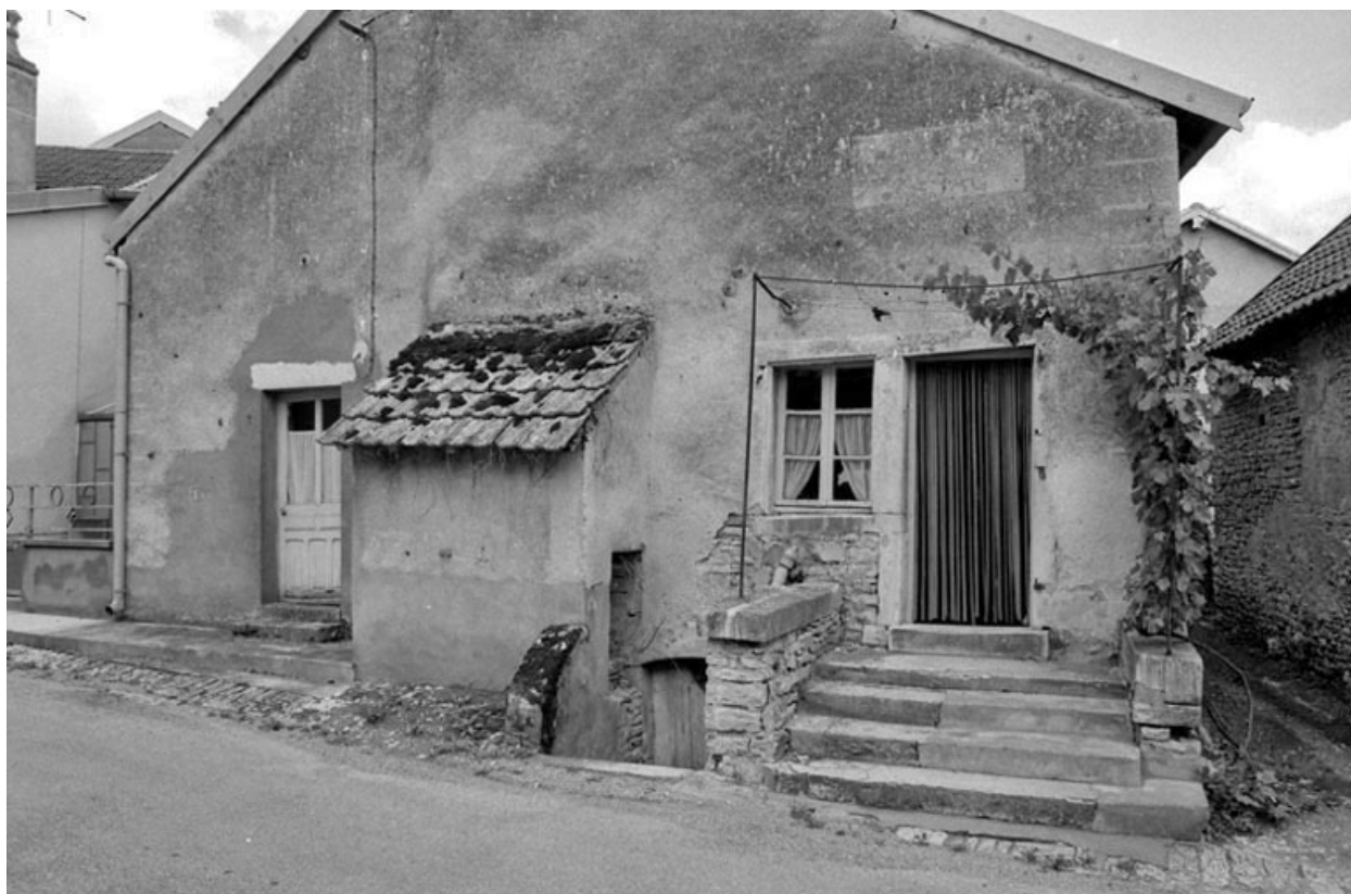
Maison située rue de Bresilley.
