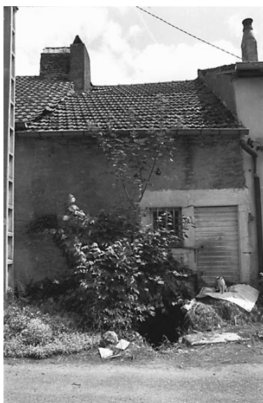
Maison située rue Neuve. Phot. Bernard Lardière IVR43_19817000514Z
