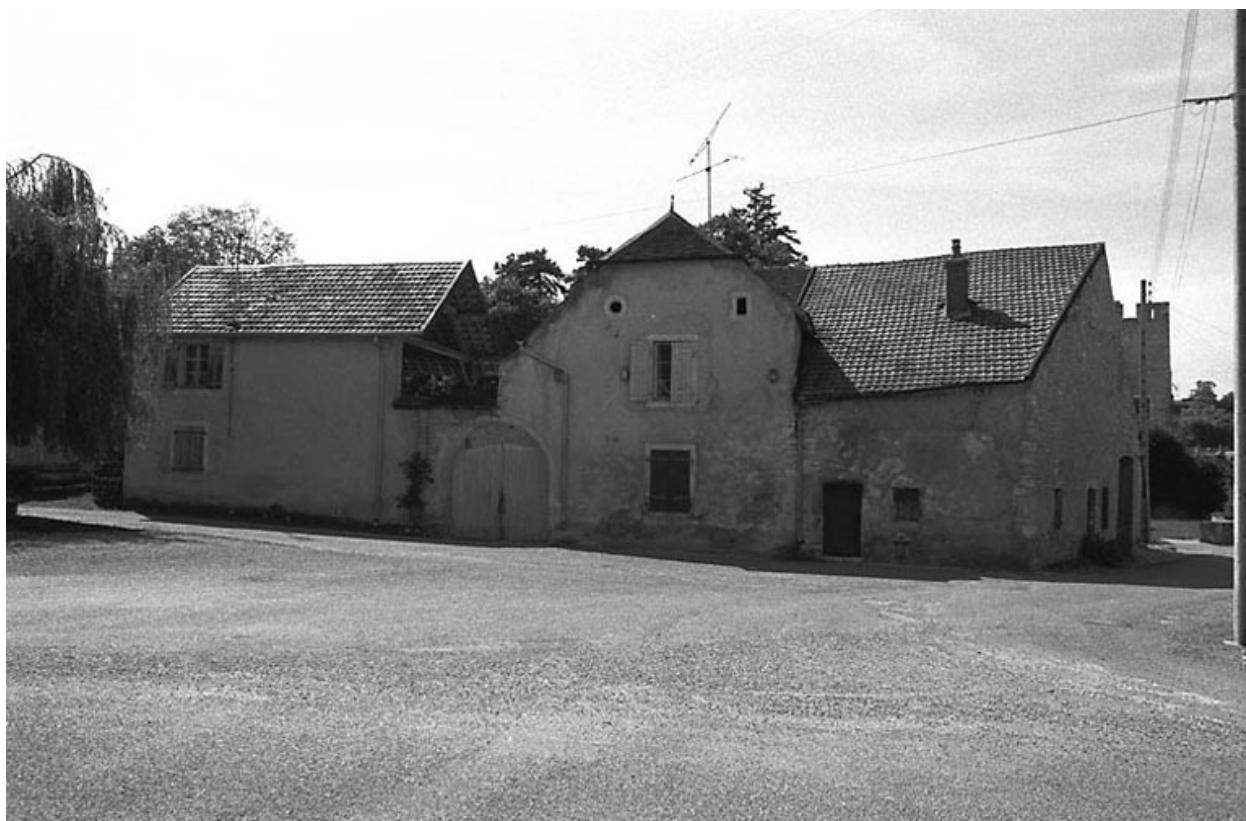
Ferme située rue de Barrey
