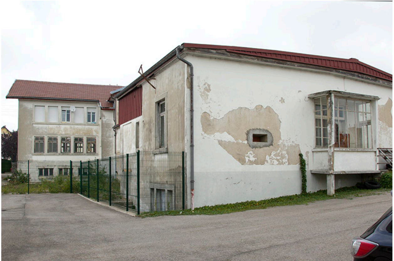
Façade postérieure et extensions.
