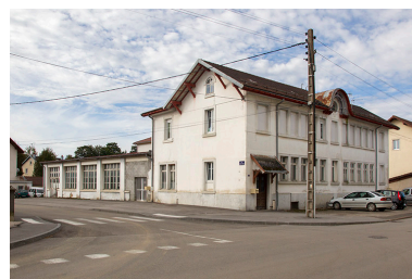
Vue d'ensemble, depuis le nord-est (façades antérieure et latérale gauche). Phot. Yves Sancey IVR43_20122502270NUC2A
