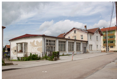
Extensions : façade sur la rue Pasteur, de trois quarts gauche. Phot. Sonia Dourlot IVR43_20142501784NUC2A
