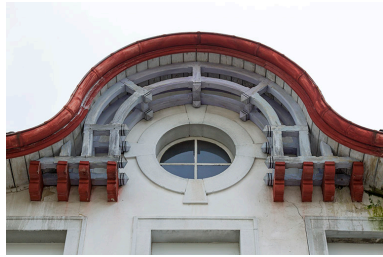
Façade antérieure : oculus vu en contre-plongée. Phot. Yves Sancey IVR43_20122502280NUC2A
