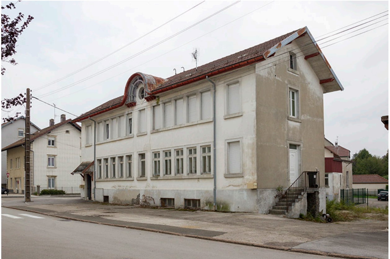
Façades antérieure et latérale droite.
