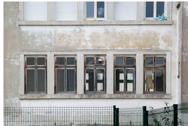
Façade postérieure : fenêtres multiples. Phot. Yves Sancey IVR43_20122502276NUC2A
