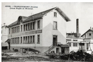
1935. - Charquemont (Doubs). Usine Pagès et Wittver, entre 1922 et 1935. Phot. IVR43_20132500067NUC1A
