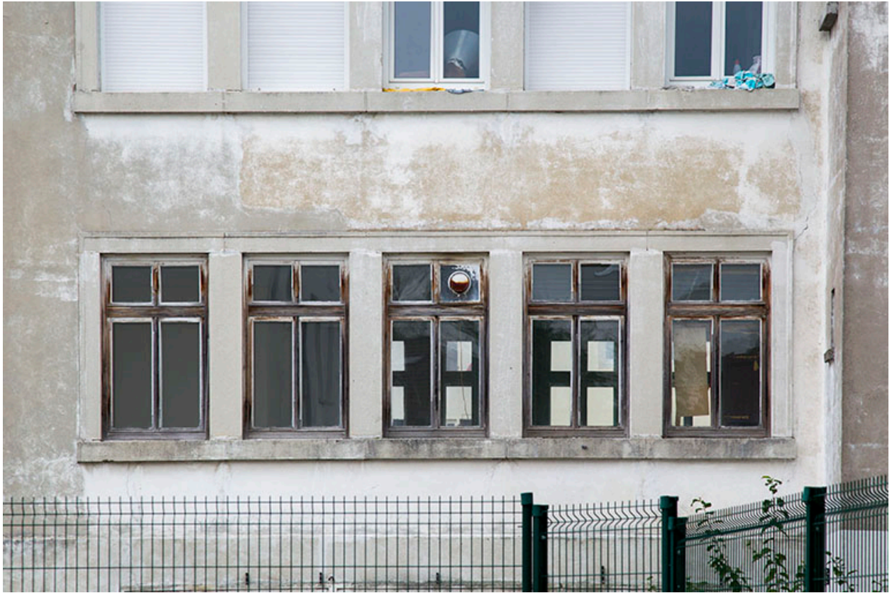
Façade postérieure : fenêtres multiples.
