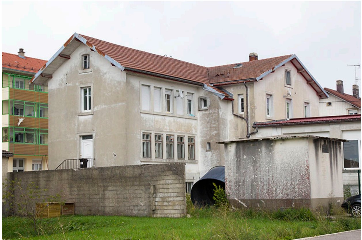
Façades postérieure et latérale droite.
