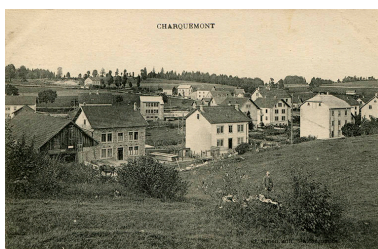
Charquemont [la Rue Neuve et le quartier de la gare, depuis le sud], décennie 1910. Vue de la façade postérieure de l'usine, dont seule la moitié droite est construite. Autr. Charles Simon IVR43_20152502077NUC4A
