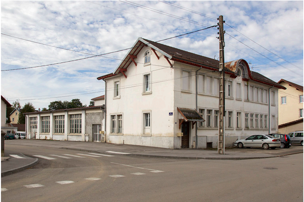
Vue d'ensemble, depuis le nord-est (façades antérieure et latérale gauche).
