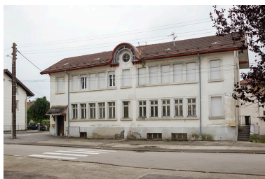
Façade antérieure, de trois quarts droite. Phot. Yves Sancey IVR43_20122502272NUC2A
