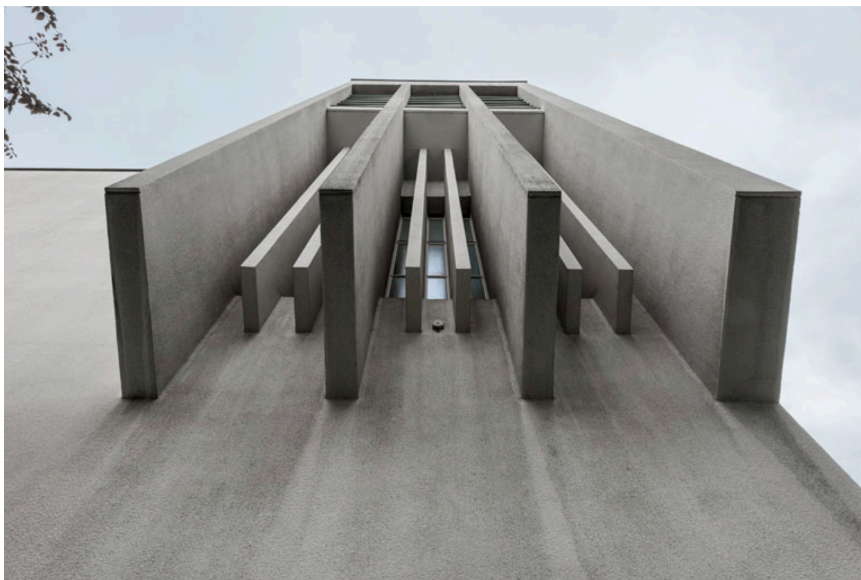
Détail du jeu de pilastres formant la console du clocher et des meneaux en béton armé (baie 102).
