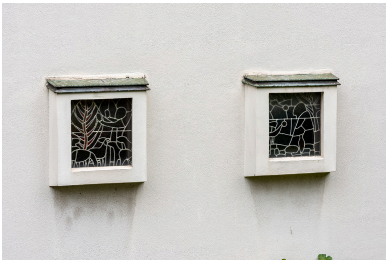
Vue extérieure de l'ensemble des deux baies avec leur verrière en vitrail (baies 0).
