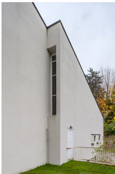
Vue de la baie verticale sur la saillie du mur ouest (baie 2). Phot. Pierre-Marie Barbe-Richaud IVR26_20227100211NUC4A
