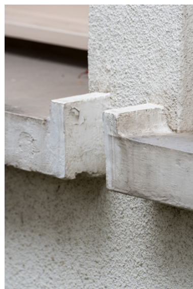
Détail des appuis saillants des baies de la façade nord (baie 4). Phot. Pierre-Marie Barbe-Richaud IVR26_20227100214NUC4A
