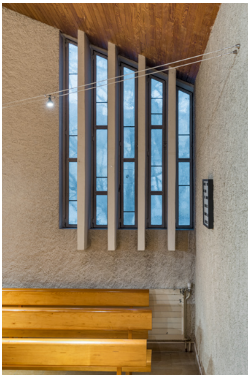
Vue intérieure de la baie du mur est (baie 3).
