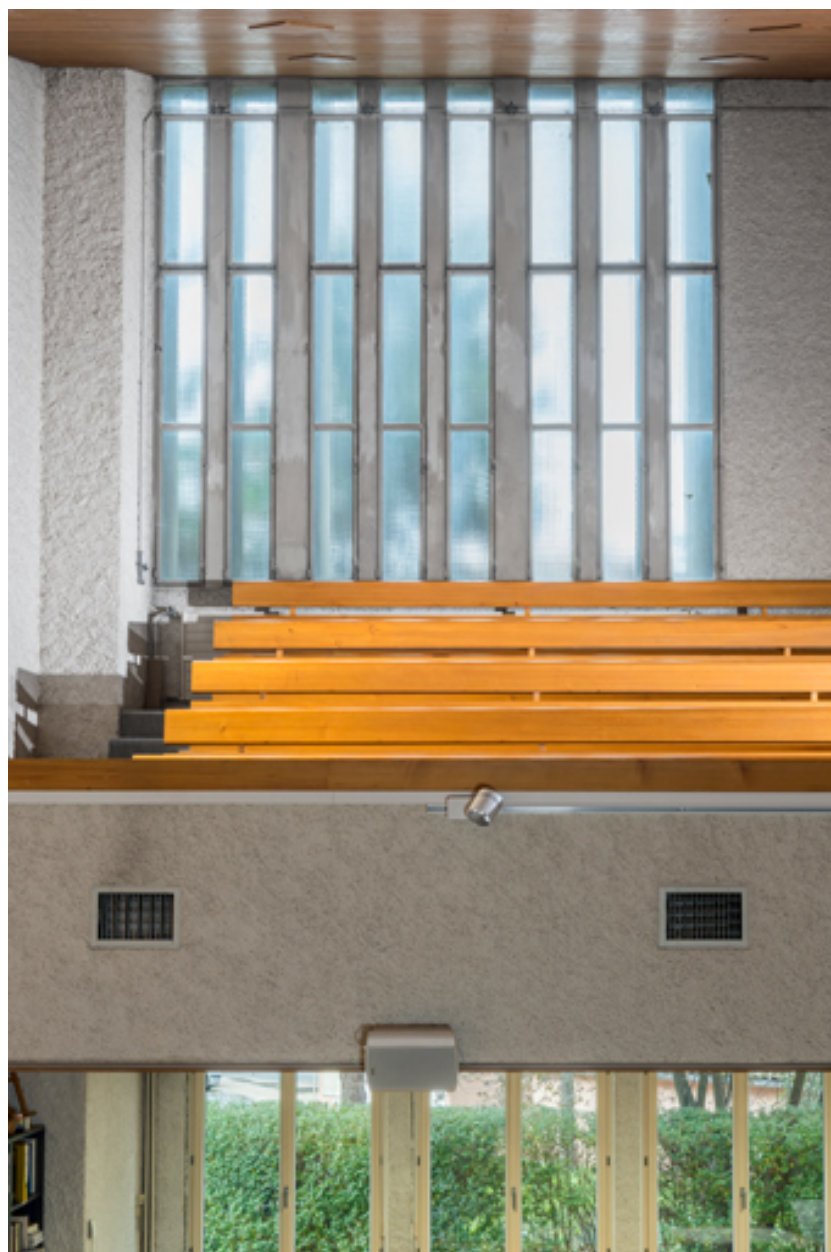
Vue de la baie donnant sur la tribune (baie 102).
