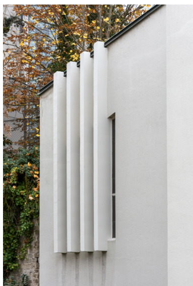
Détail de la baie de la façade est (baie 3). Phot. Pierre-Marie Barbe-Richaud IVR26_20227100205NUC4A
