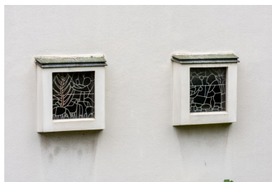
Vue extérieure de l'ensemble des deux baies avec leur verrière en vitrail (baies 0). Phot. Pierre-Marie Barbe-Richaud IVR26_20227100217NUC4A
