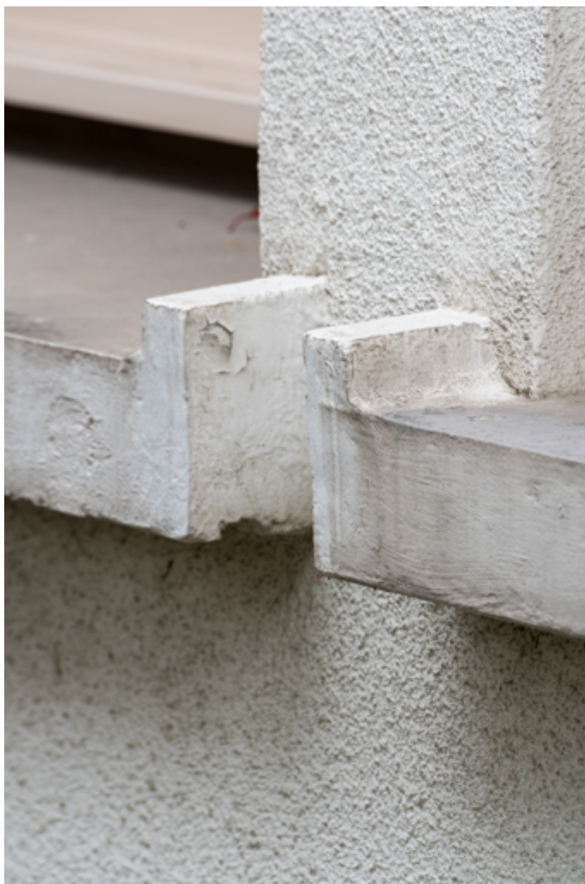
Détail des appuis saillants des baies de la façade nord (baie 4).
