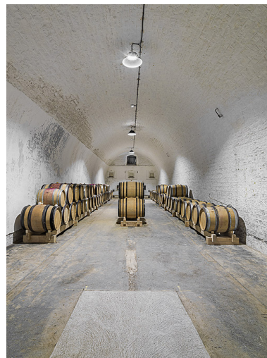
La chambre de stockage de la poudre. Sur le mur en arrière plan, les baies éclairant cette pièce. Phot. Thierry Kuntz IVR26_20252100426NUC4A
