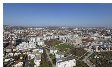
Site de l'ancien arsenal. (vue aérienne). Phot. Nicolas Douriaux IVR26_20262100319NUC4A
