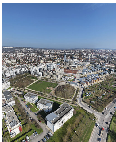
Site de l'ancien arsenal. (vue aérienne). Phot. Nicolas Douriaux IVR26_20262100318NUC4A
