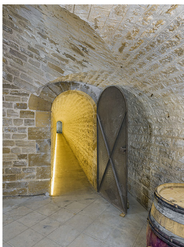
Galerie d'assainissement (droite). Phot. Thierry Kuntz IVR26_20252100427NUC4A
