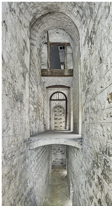
Seconde chambre d'éclairage. Au niveau inférieur se situe le vide sanitaire. Phot. Thierry Kuntz IVR26_20252100433NUC4A
