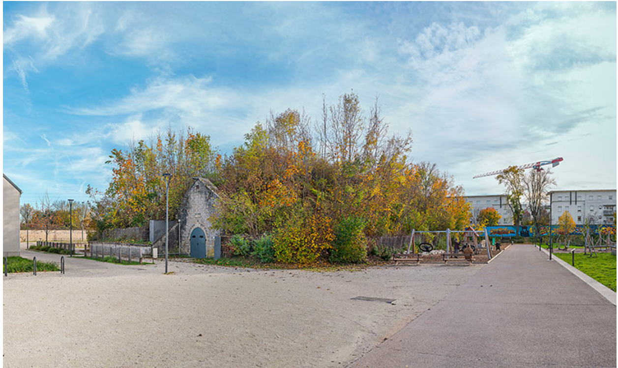
Vue de trois quarts droit du magasin V1.
