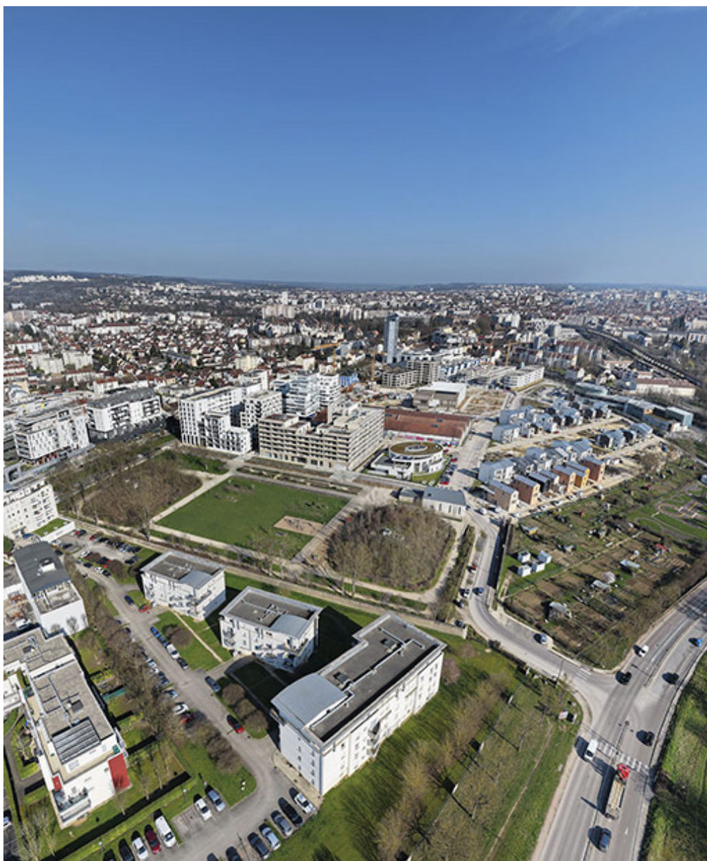
Site de l'ancien arsenal. (vue aérienne).
