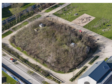
Le magasin V1. (vue aérienne). Phot. Nicolas Douriaux IVR26_20262100404NUC4A
