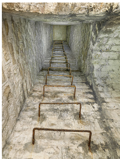
Echelle métallique d'un puits d'aération et de lumière. Phot. Thierry Kuntz IVR26_20252100434NUC4A
