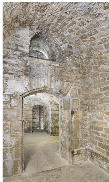
Le vestibule d'entrée. Au fond, la galerie d'assainissement (gauche). Phot. Thierry Kuntz IVR26_20252100430NUC4A
