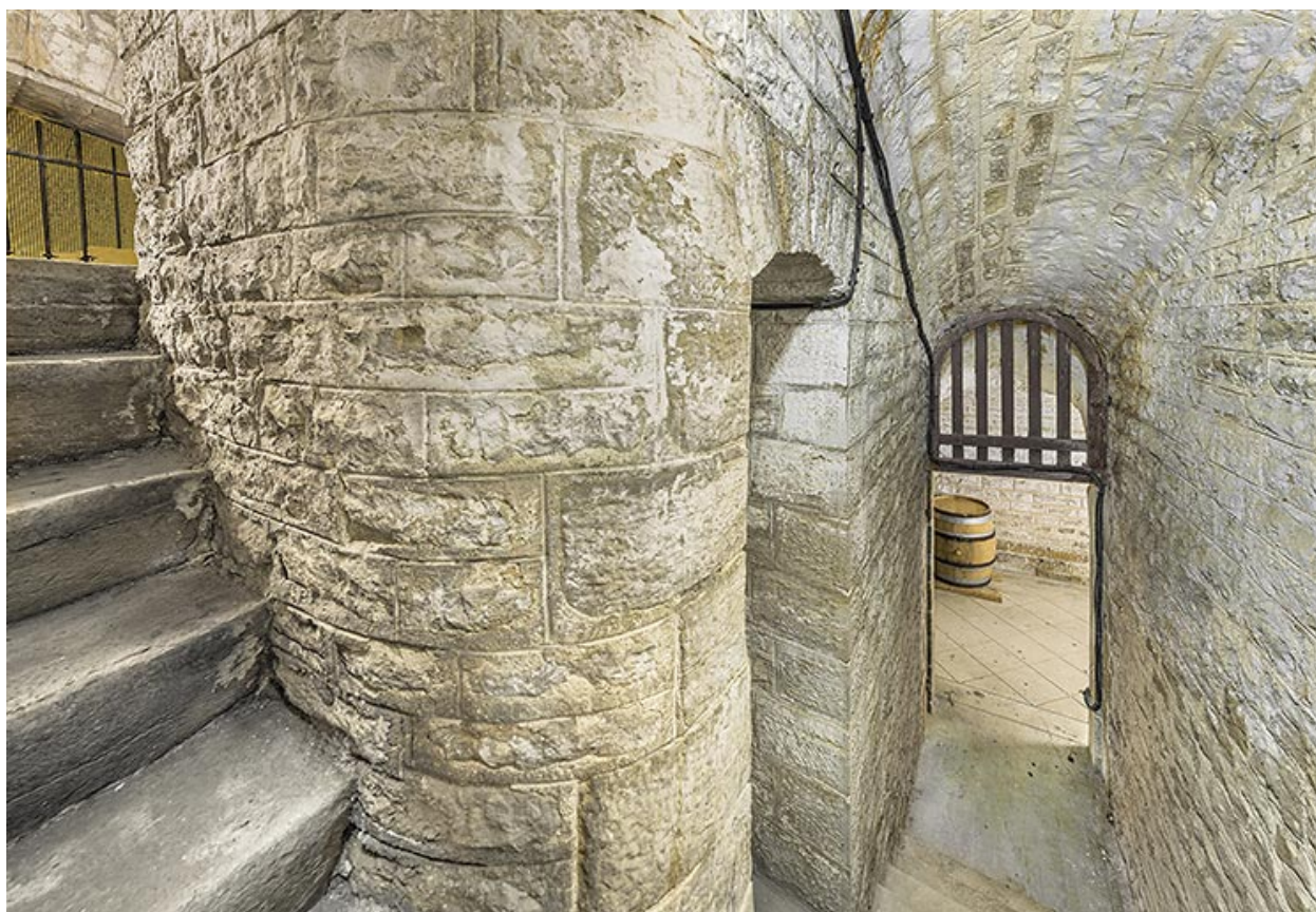
L'escalier d'accès à la chambre d'éclairage au-dessus du vestibule d'entrée.
