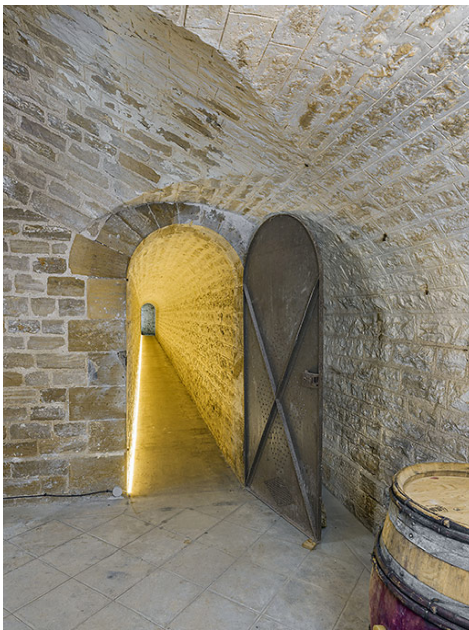
Galerie d'assainissement (droite).
