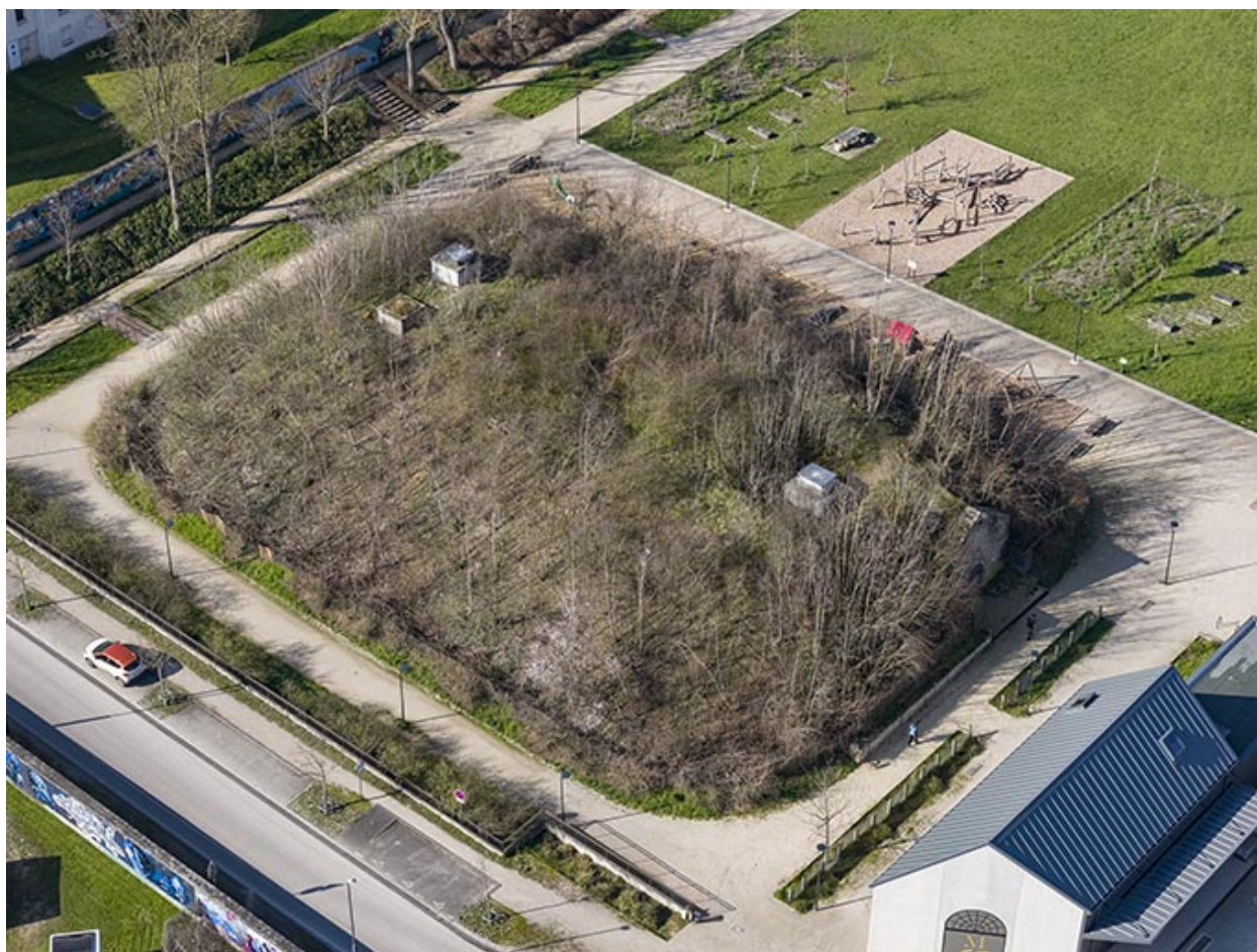
Le magasin V1. (vue aérienne).
