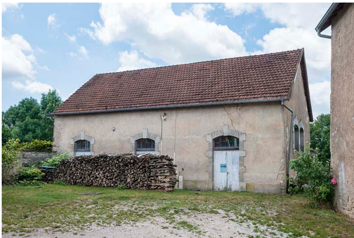
Le bâtiments servant d'abattoir.
