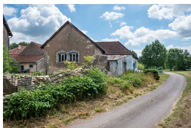
Mur pignon ouest. Phot. Jérôme Mongreville IVR43_20177001010NUC4A
