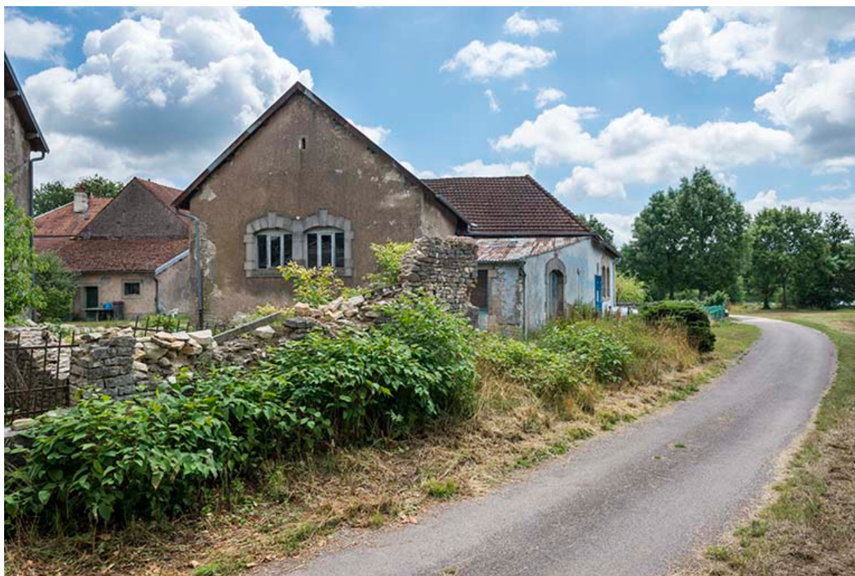
Mur pignon ouest.
