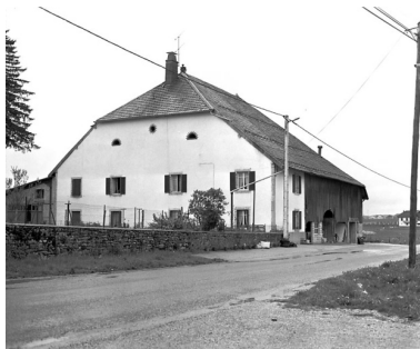
Ferme située rue Laurent Trouttet. Phot. Yves Sancey IVR43_19812500162X
