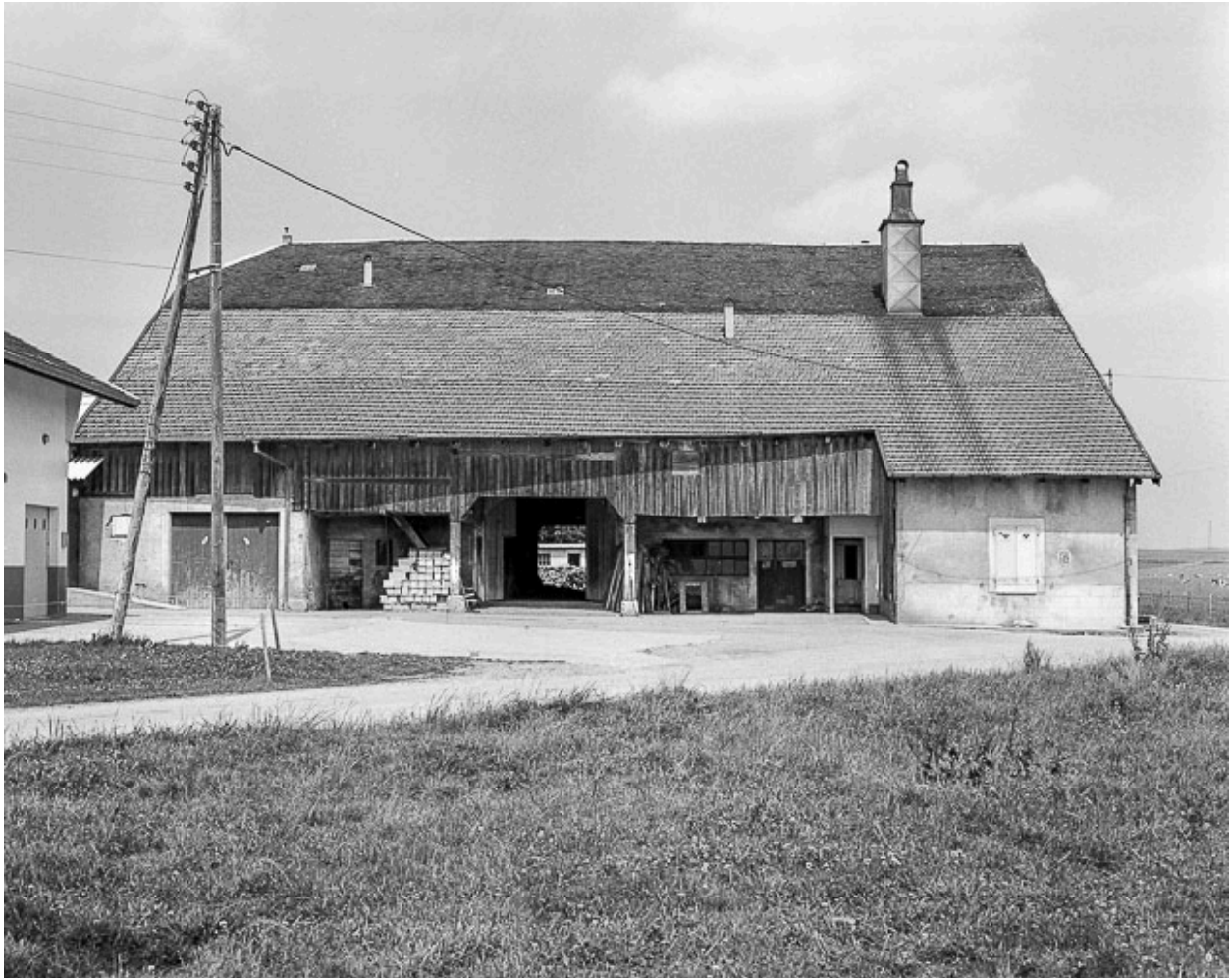
Façade latérale droite d'une ferme.
