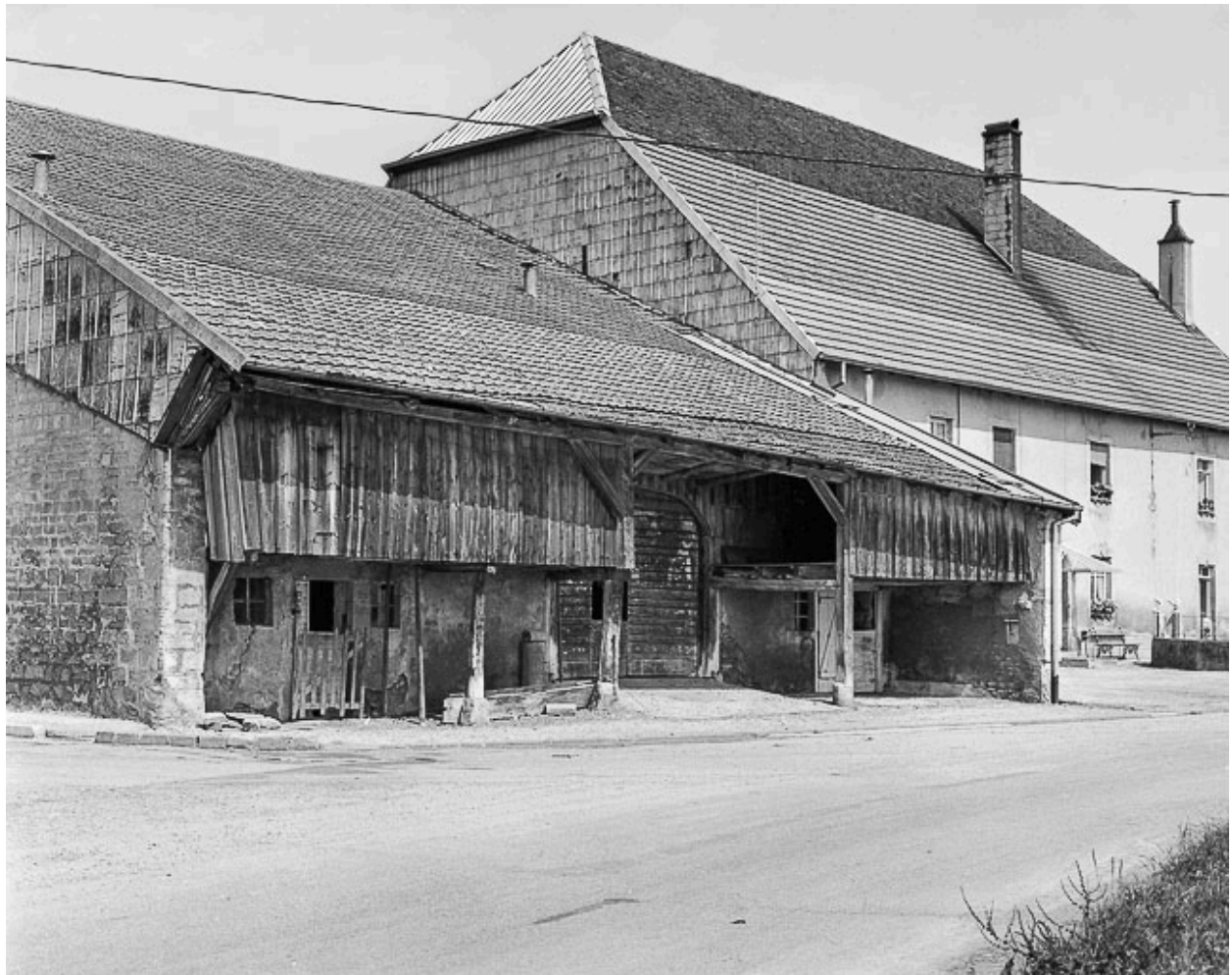
Façade sur rue d'une ferme.
