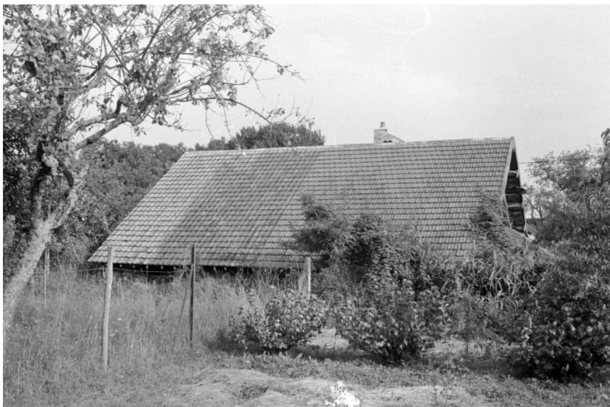
Halle de séchage (C), depuis le nord.
