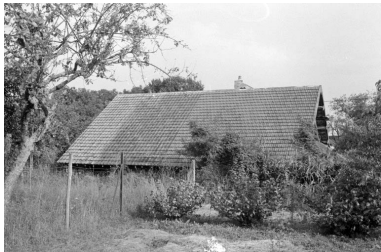
Halle de séchage (C), depuis le nord. Phot. Laurent Poupard IVR43_19883900567Z
