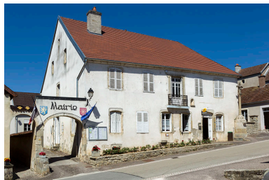
Façade antérieure, de trois quarts gauche. Phot. Sonia Dourlot IVR43_20157000396NUC2A
