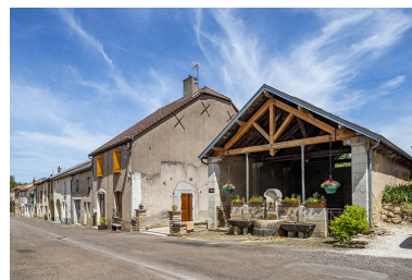
Trois quarts droit du lavoir. Phot. Jérôme Mongreville IVR43_20217000410NUC4A
