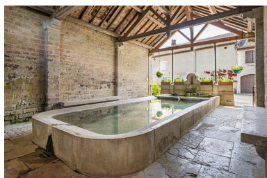
L'intérieur du lavoir, de trois quarts. Phot. Jérôme Mongreville IVR43_20217000413NUC4A
