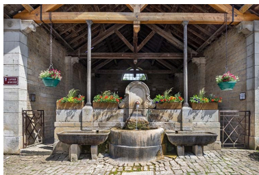
Détail de la face antérieure du lavoir. Phot. Jérôme Mongreville IVR43_20217000411NUC4A
