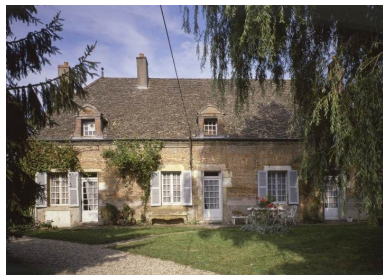
Vue d'ensemble. Phot. Michel Rosso IVR26_19862101571VA
