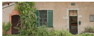
Détail des baies de la maison éclusière. Phot. Pierre-Marie Barbe-Richaud IVR26_20112103718NUC4AQ
