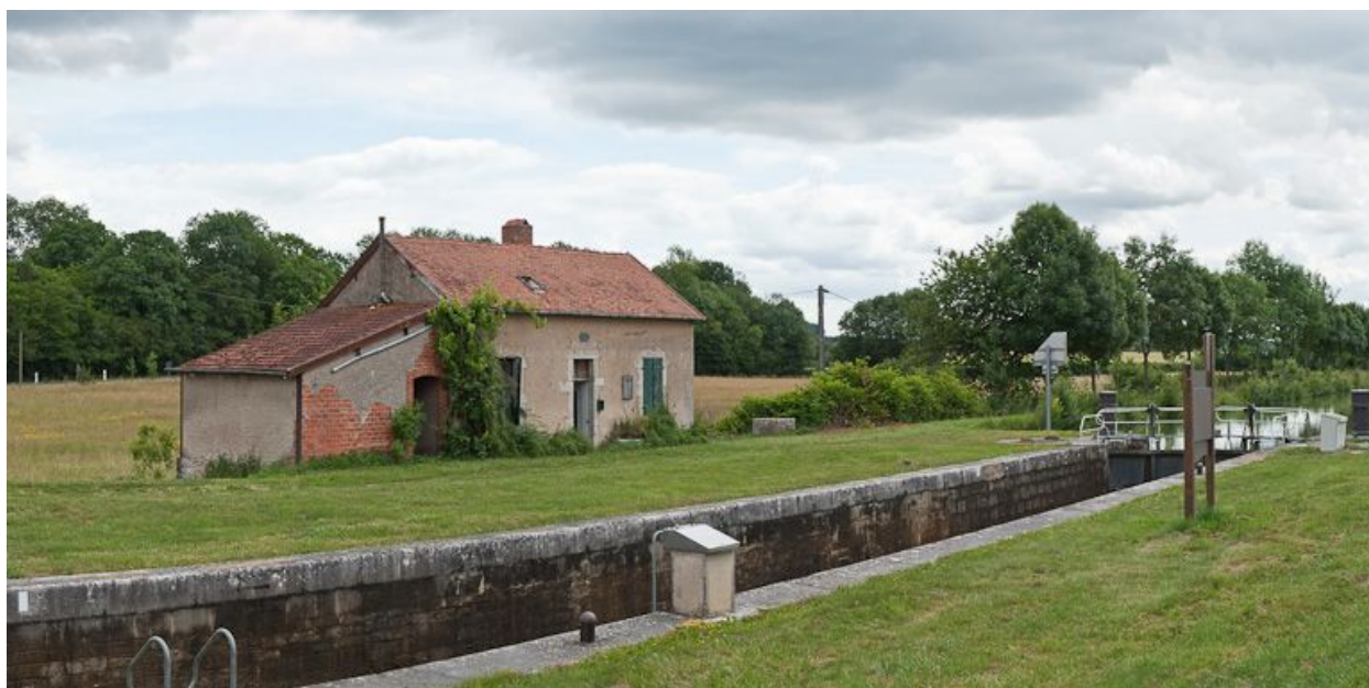
Vue d'ensemble du site d'écluse.
