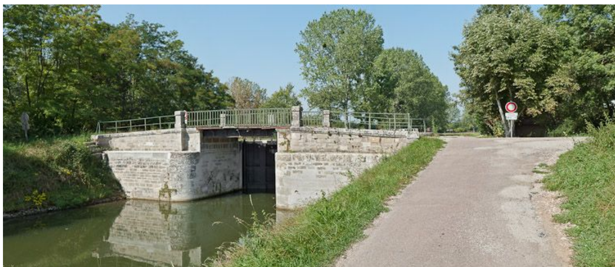
Vue du pont sur écluse depuis l'aval.
