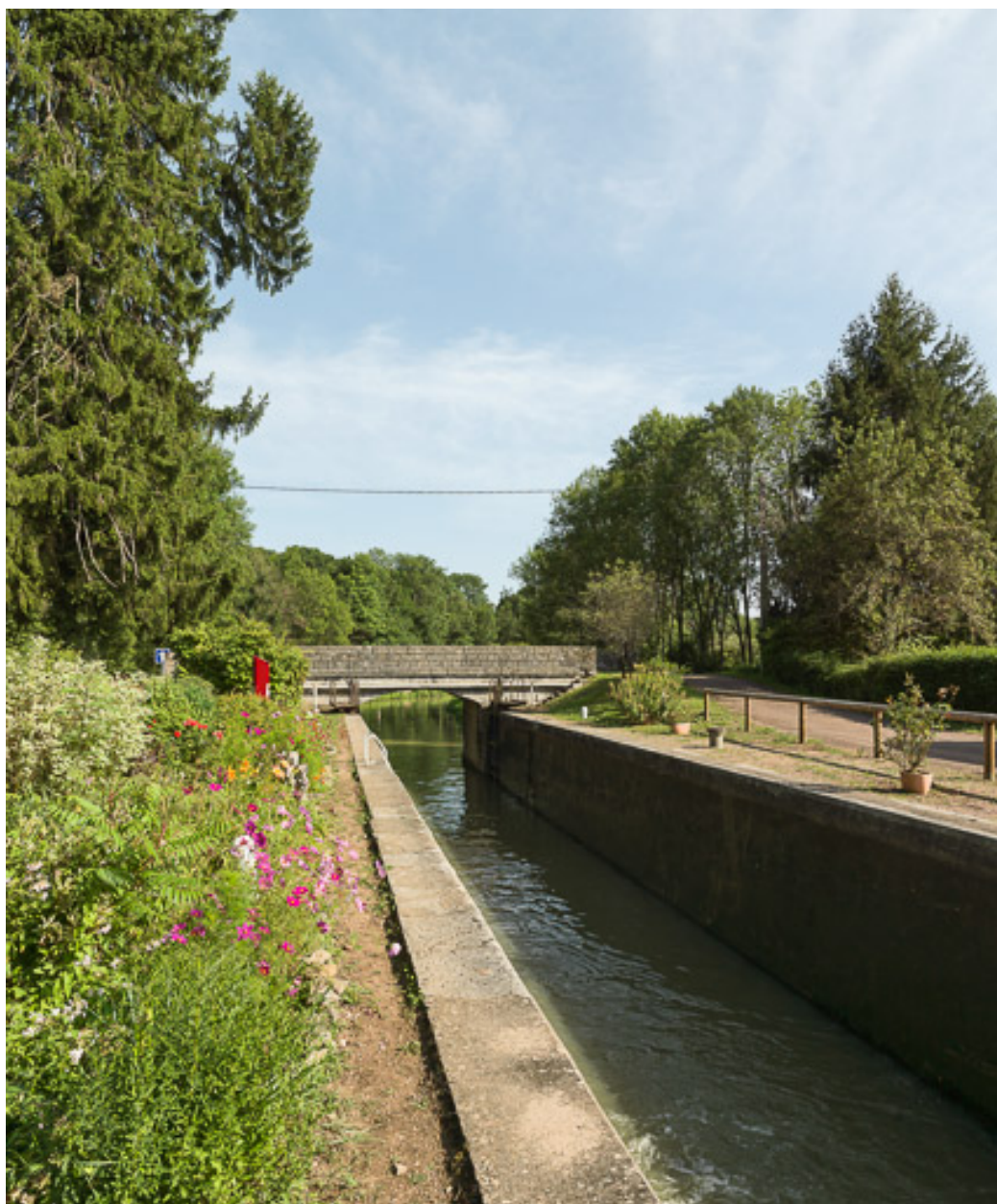
Vue du sas et du pont.
