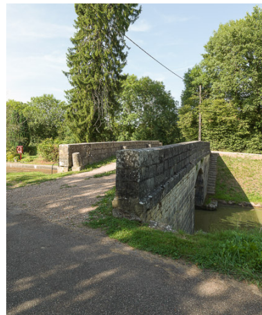
Vue du pont. Phot. Pierre-Marie Barbe-Richaud IVR26_20175800146NUC2A
