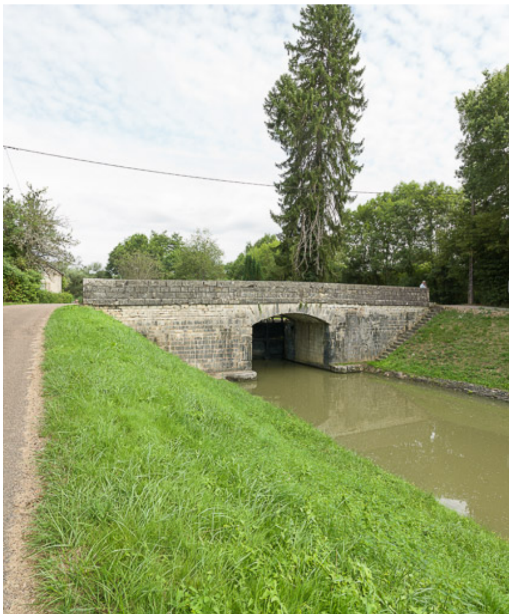
Vue d'ensemble du pont.
