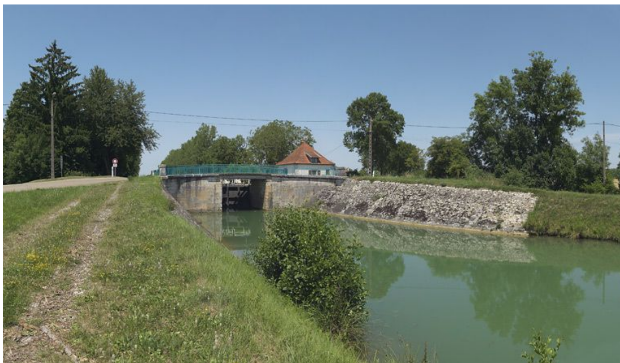
Vue d'ensemble prise d'aval.
