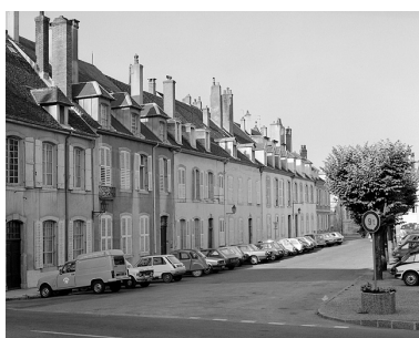
Maisons des chanoinesse. Vue d'ensemble : 1 à 13 place Bichat. Phot. Yves Sancey IVR43_19833900146X
