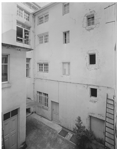
Galleries de liaison de l'ancien hôtel. Phot. Jérôme Mongreville IVR43_19872501263V
