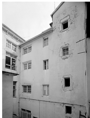
Galleries de liaison de l'ancien hôtel. Phot. Jérôme Mongreville IVR43_19872501160V
