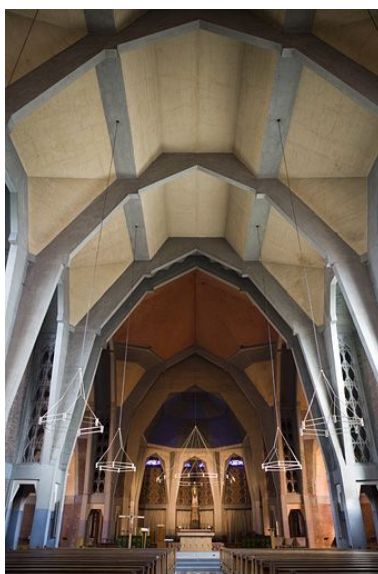
Plafond de la nef. Phot. Yves Sancey IVR43_20062500699NUCA
