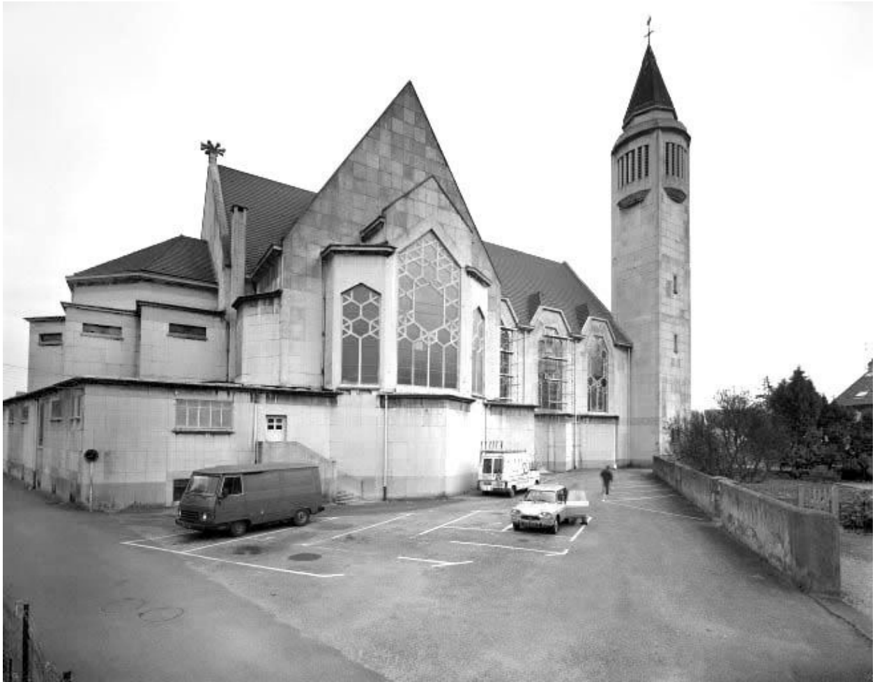
Chevet et façade latérale gauche.
