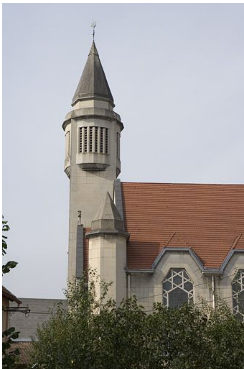
Vue générale de la partie avant de l'église.
