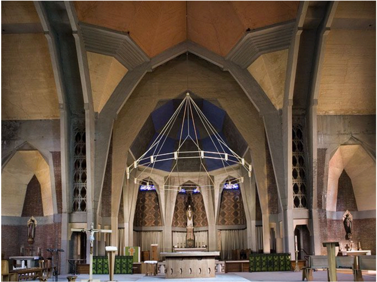
Vue générale du chœur.
