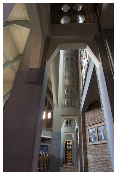
Déambulatoire : détail du décor. Phot. Yves Sancey IVR43_20062500706NUCA
