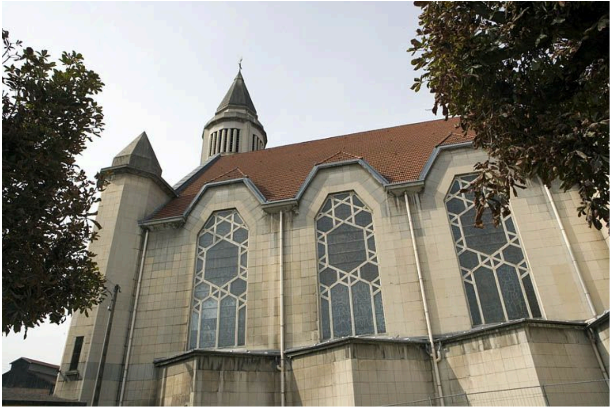
Vue extérieure de la nef.
