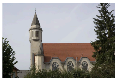
Vue extérieure d'ensemble latérale. Phot. Yves Sancey IVR43_20062500714NUCA
