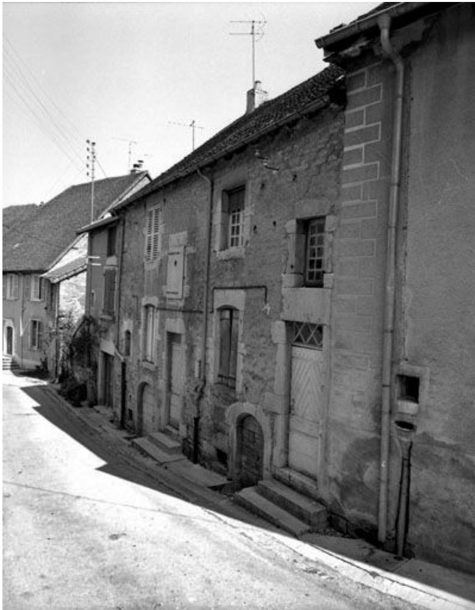
Maison de vigneron située rue des Vignerons.
