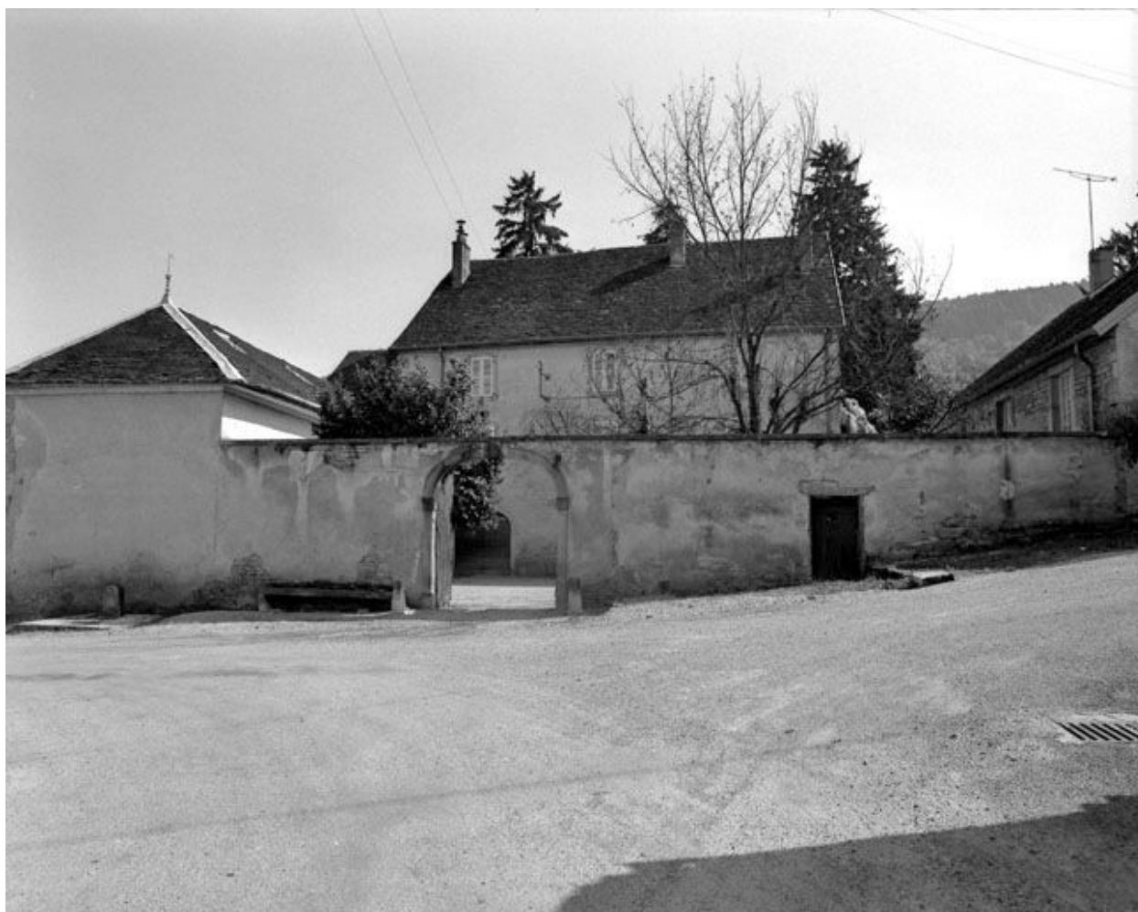
Maison de vigneron située rue Lacuzon.
