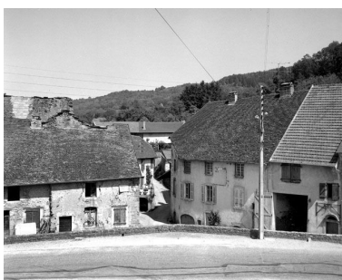
Ferme de vigneron située rue du Château. Phot. Yves Sancey IVR43_19843900353X
