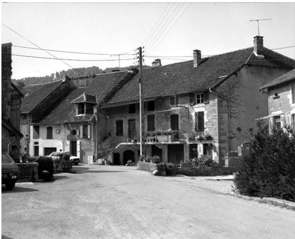
Maison située rue des Vignerons.
