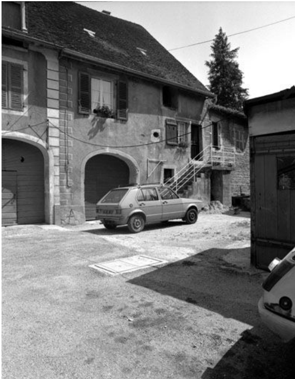
Ferme de vigneron située rue Traversière.
