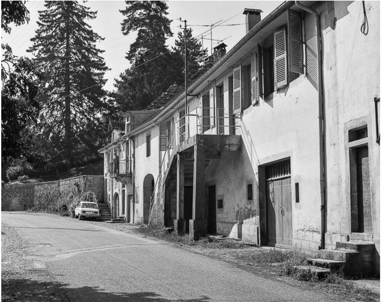
Ferme de vigneron située rue de la Liberté.
