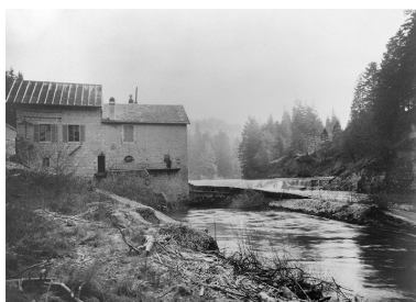
Vue générale, 1950-1951. Phot. Yves Sancey, Autr. R. Ponget IVR43_19883900720V
