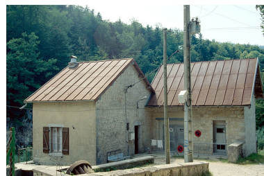
Façade antérieure. Phot. Laurent Poupard IVR43_19923901431ZA
