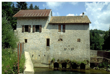
Façade latérale droite. Phot. Laurent Poupard IVR43_19923901435ZA
