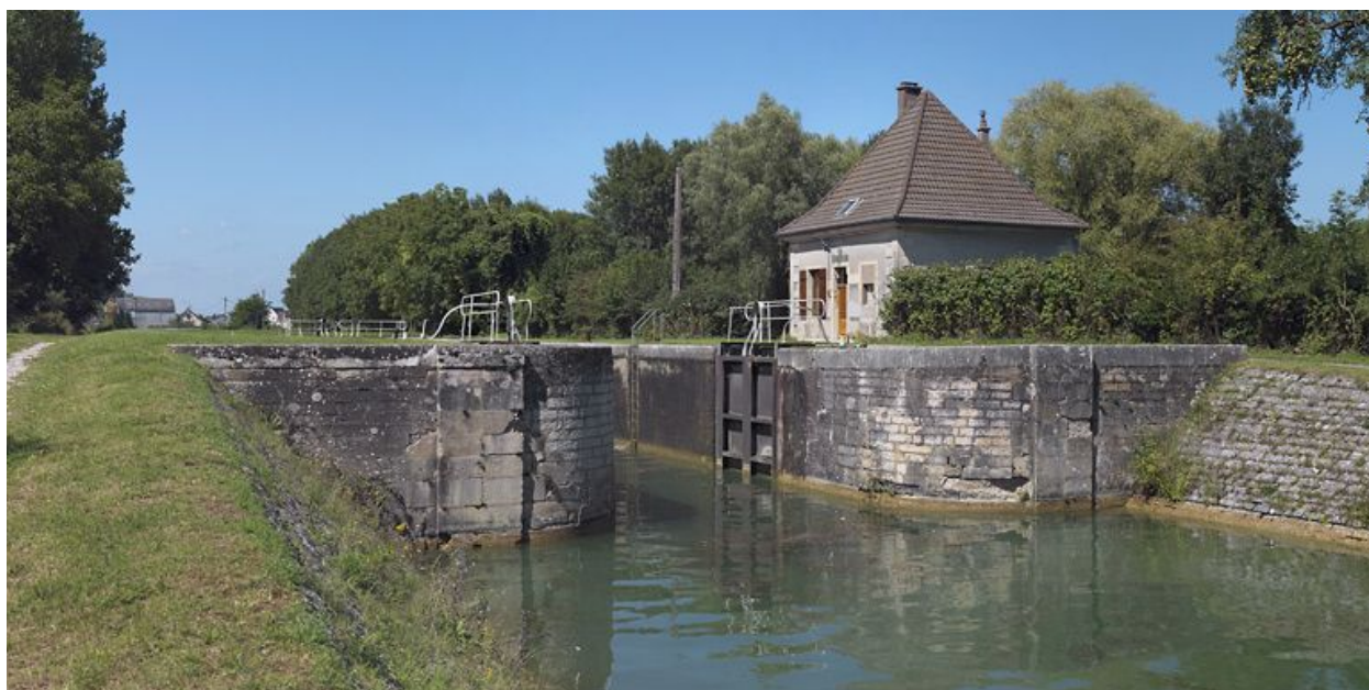
Site vu d'aval.
