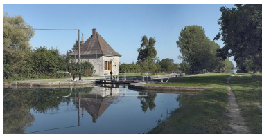
Vue d'amont. Phot. Thierry Kuntz IVR26_20112103145NUC4A
