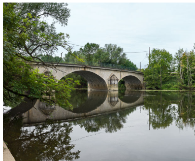
Vue d'ensemble du pont. Phot. Pierre-Marie Barbe-Richaud IVR26_20178900155NUC2AQ
