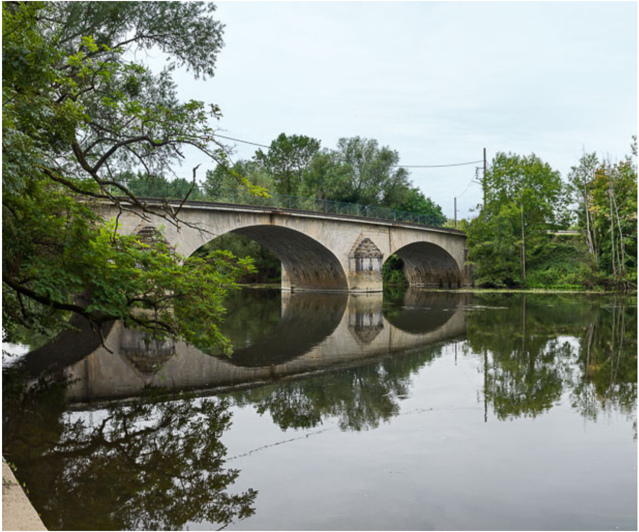
Vue d'ensemble du pont.
