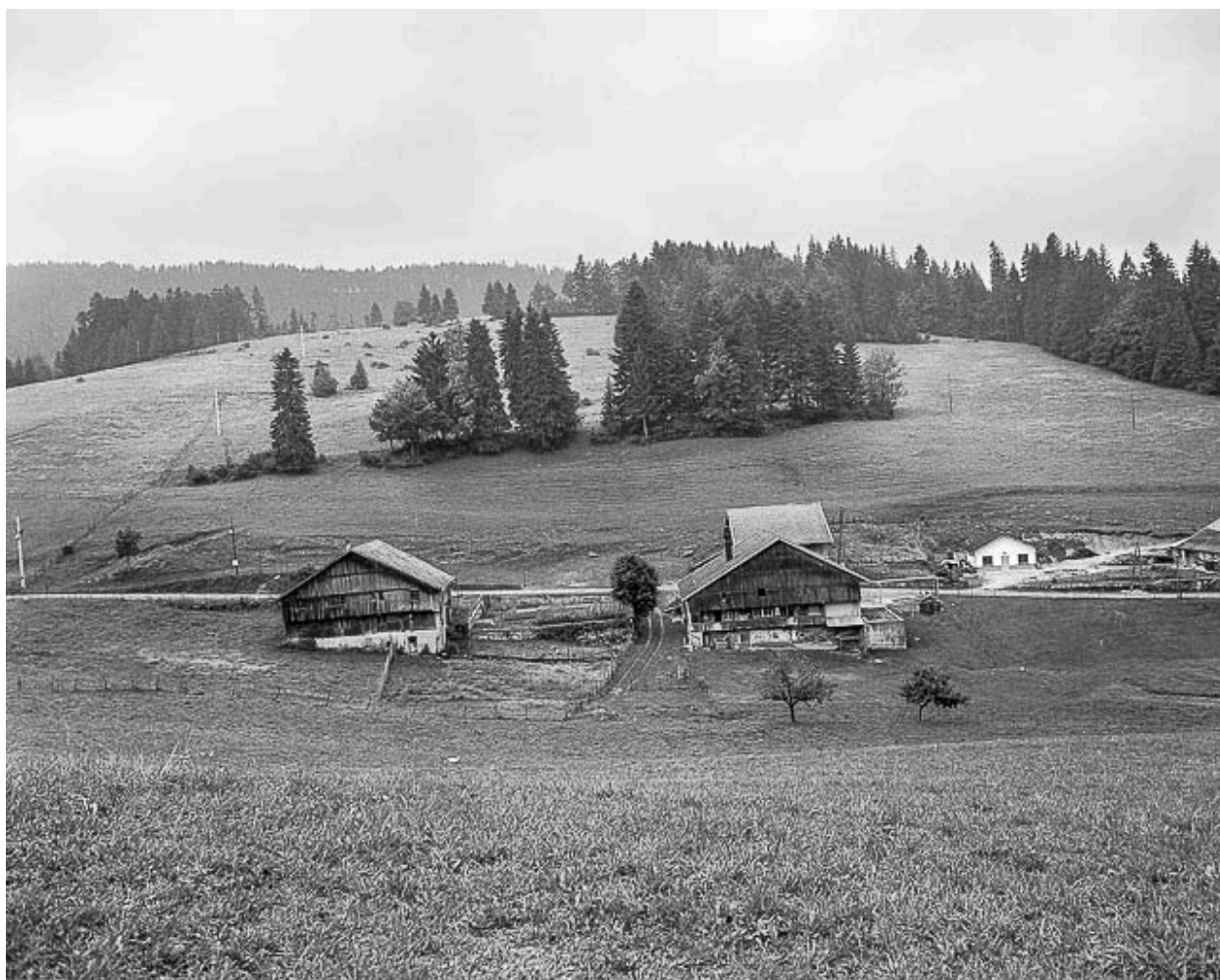
Fermes situées au lieudit Le Mont Dessus : vue d'ensemble.
