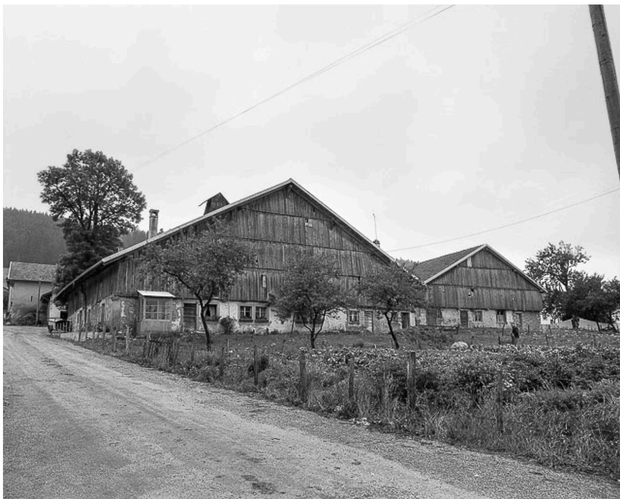
Fermes situées au lieudit Chinard : facades antérieures.
