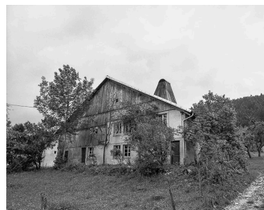
Ferme cadastrée 1966 AE 97 : façade antérieure. Phot. Dominique Humbert IVR43_19762500416X
