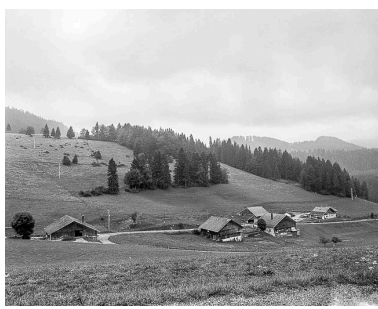
Fermes situées au lieudit Le Mont Dessus : vue d'ensemble. Phot. Dominique Humbert IVR43_19762500393X
