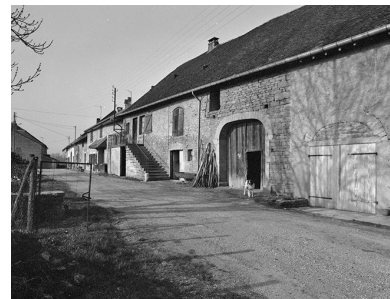
Fermes situées rue du Puits. Phot. Jérôme Mongreville IVR43_19853900080X
