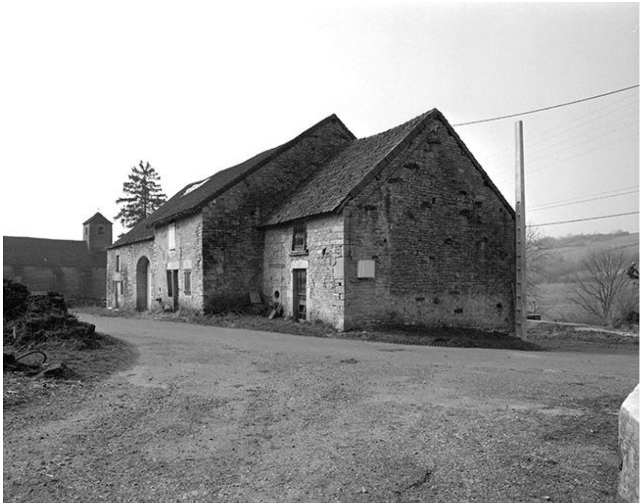
Ferme située rue de la Chapelle.
