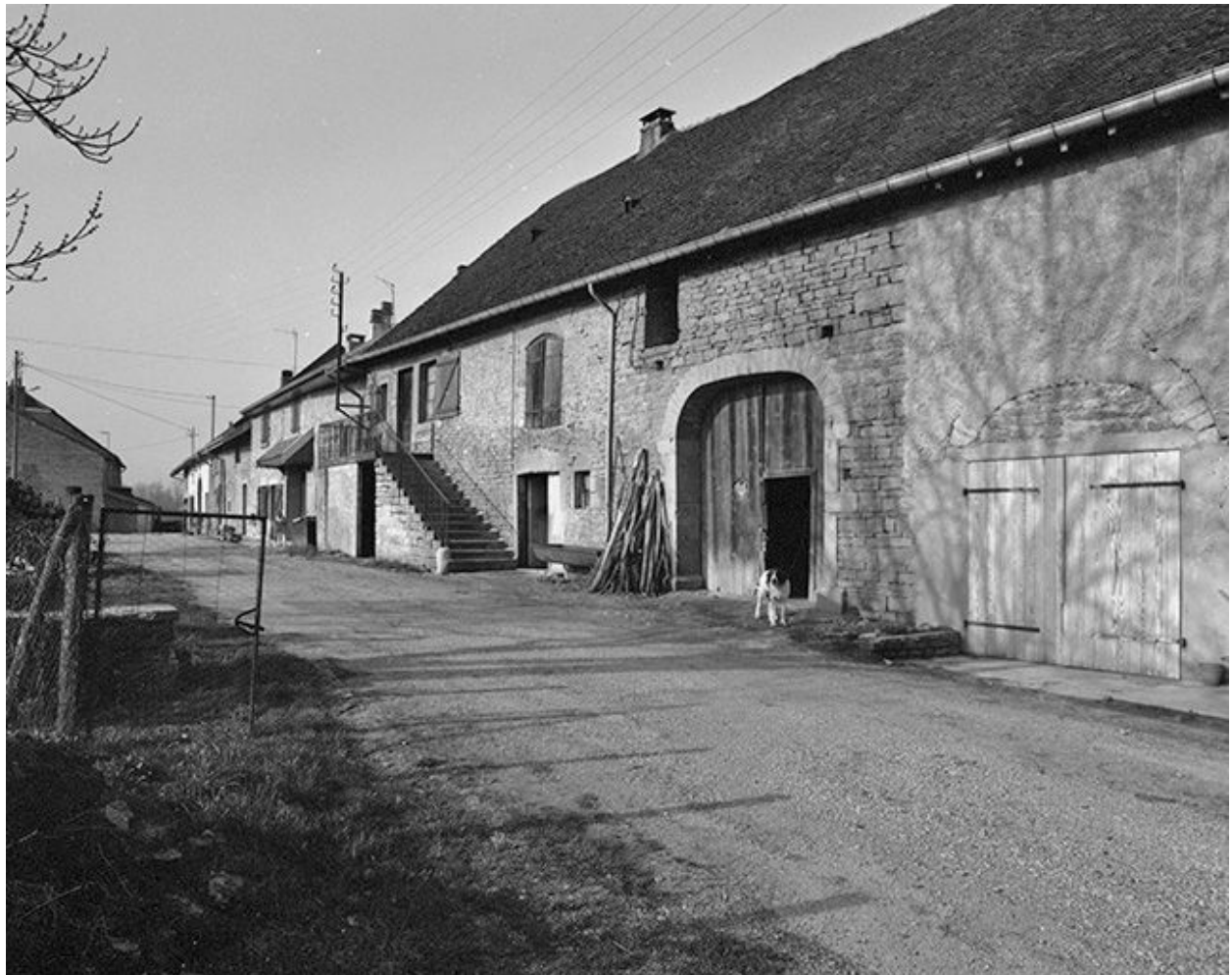
Fermes situées rue du Puits.
