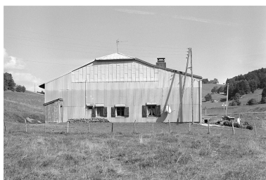
Face sud-ouest. Phot. Jérôme Mongreville IVR43_19963901239X
