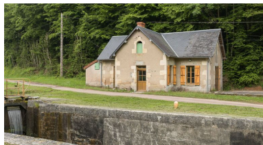
La maison éclusière de 3/4. Phot. Pierre-Marie Barbe-Richaud IVR26_20135800405NUC4AQ
