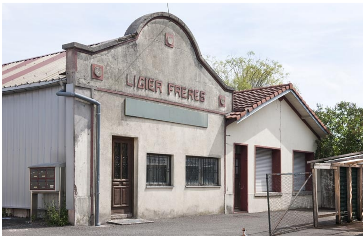
Pignon de l'atelier de fabrication originel.
