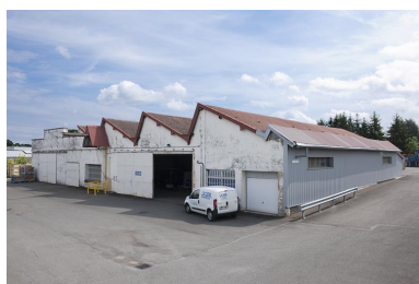
Atelier de fabrication ouest. Phot. Jérôme Mongreville IVR43_20112501146NUC4A
