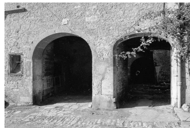
Détail de la façade sur rue. Phot. Bernard Lardière IVR43_19797000404Z
