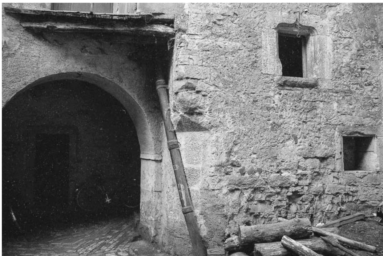
Accès à la tour d'escalier.
