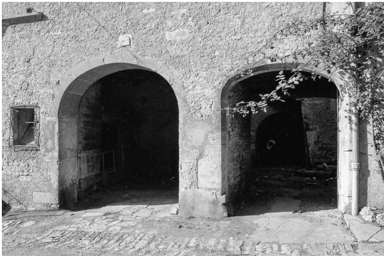
Détail de la façade sur rue.
