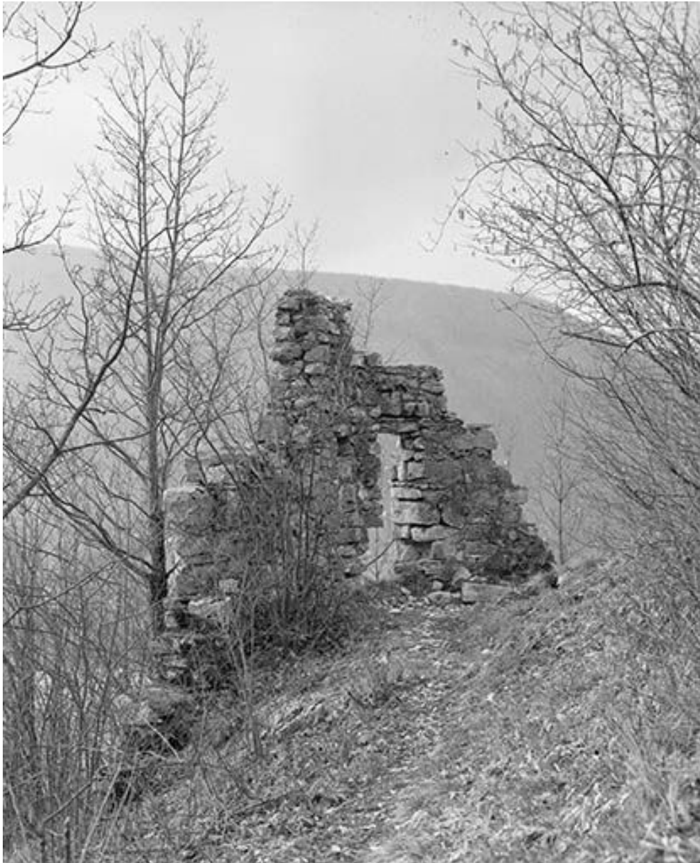
Détail : face interne de l'enceinte.
