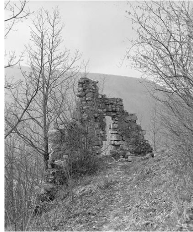
Détail : face interne de l'enceinte. Phot. Yves Sancey IVR43_19822500185X
