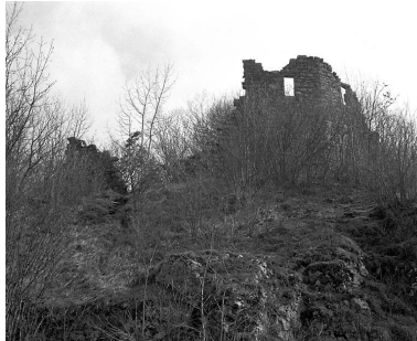
Elévation du côté de la vallée. Phot. Yves Sancey IVR43_19822500186X
