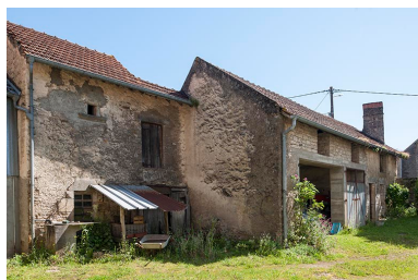
communs du château. Phot. Jérôme Mongreville IVR43_20167001024NUC4A
