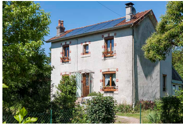
Maison située vers l'entrée du village. Phot. Jérôme Mongreville IVR43_20167001064NUC4A
