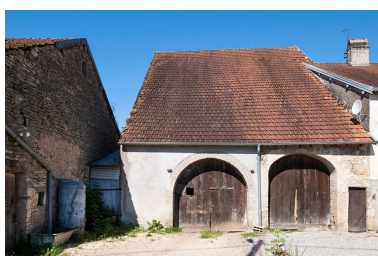
Grange à deux portes charretières. Phot. Jérôme Mongreville IVR43_20167001014NUC4A
