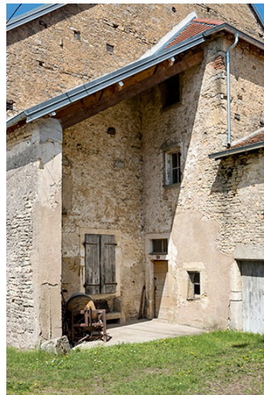
La partie abritée de la façade antérieure. Phot. Sonia Dourlot IVR43_20167000550NUC4A
