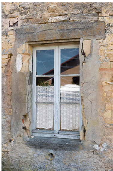
Détail d'une ouverture, mur pignon. Phot. Sonia Dourlot IVR43_20167000552NUC4A
