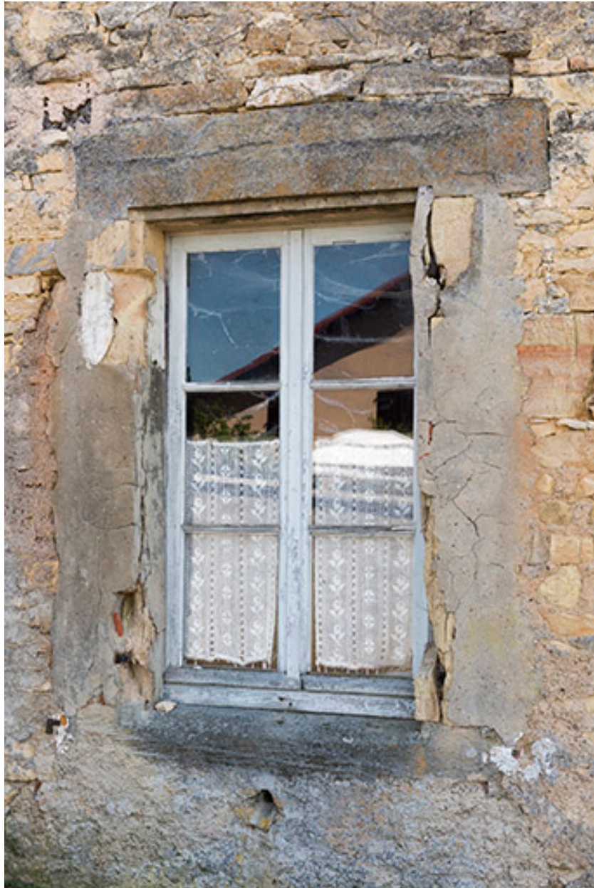
Détail d'une ouverture, mur pignon.
