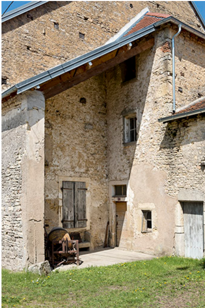
La partie abritée de la façade antérieure.
