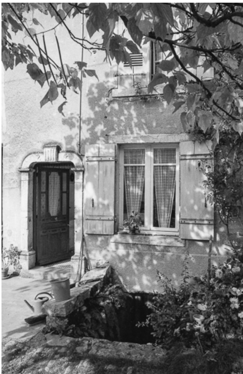
Détail : entrées de cave et d'habitation.
