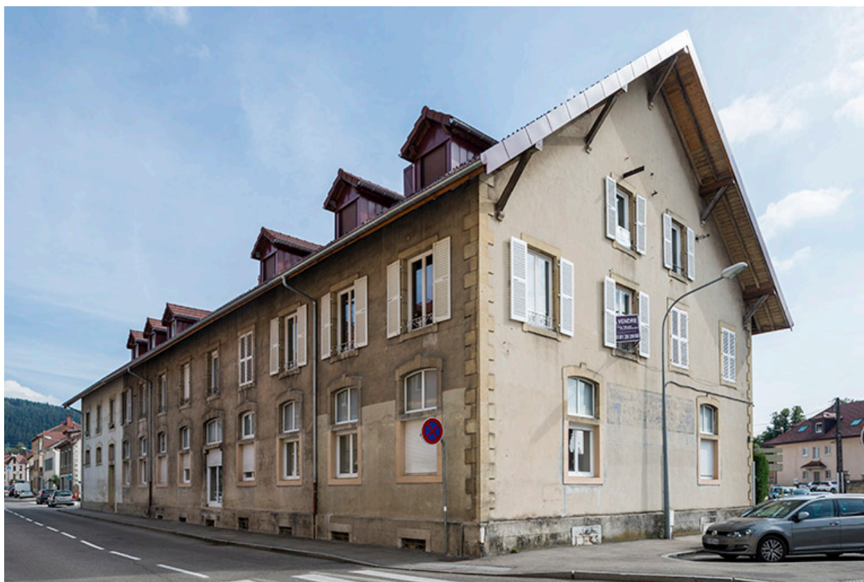
Façade nord et pignon ouest.
