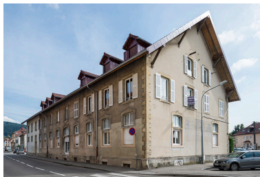
Façade nord et pignon ouest. Phot. Jérôme Mongreville IVR43_20162501192NUC4A
