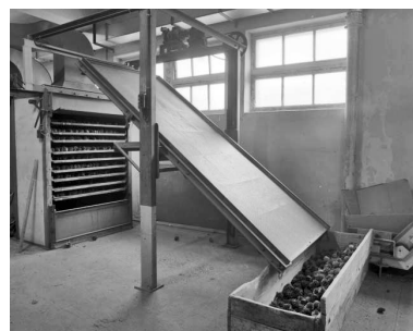
Séchoir ouvert et grille basculée. Phot. Jérôme Mongreville IVR43_19973900306X
