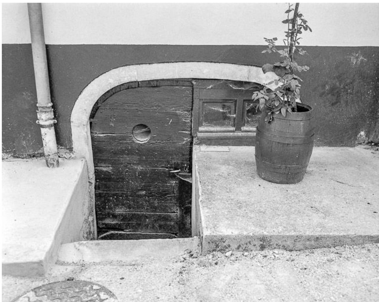
Maison : entrée de la cave.
