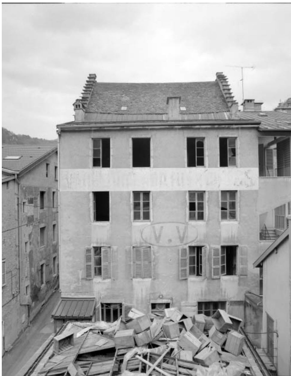
Immeuble : façade postérieure.
