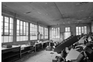
Atelier dans la cour : intérieur. Phot. Laurent Poupard IVR43_19913901624Z
