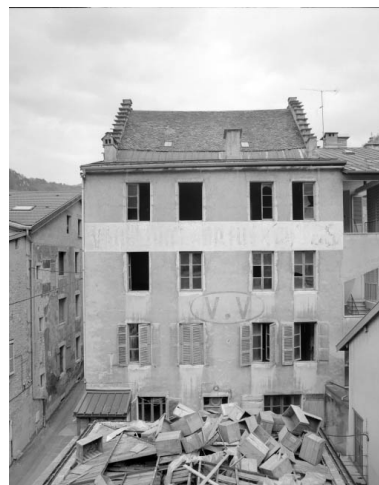
Immeuble : façade postérieure. Phot. Jérôme Mongreville IVR43_19923900341X
