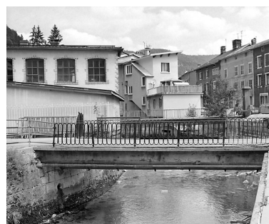
Le pont du Casino en 2000. Phot. Jérôme Mongreville IVR43_20003900395X
