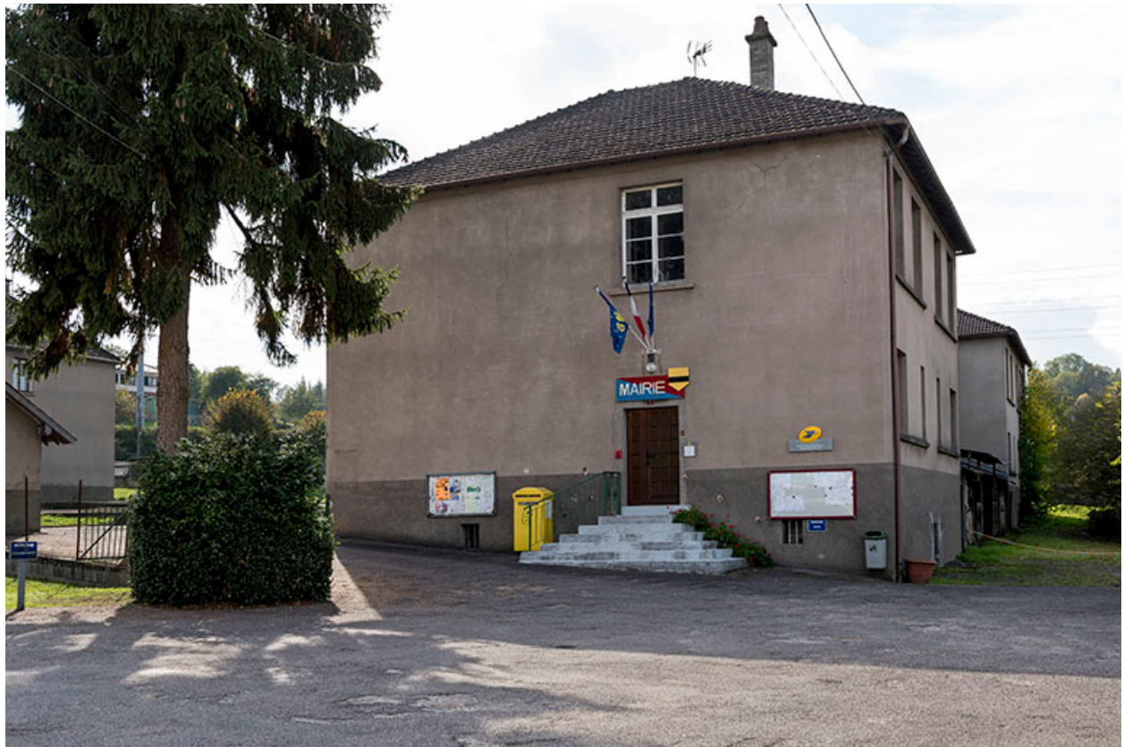
Pignon d'entrée nord-est de la mairie.
