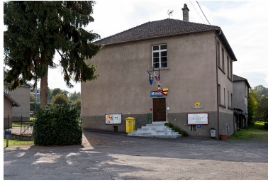
Pignon d'entrée nord-est de la mairie. Phot. Sonia Dourlot IVR43_20157001347NUC4A
