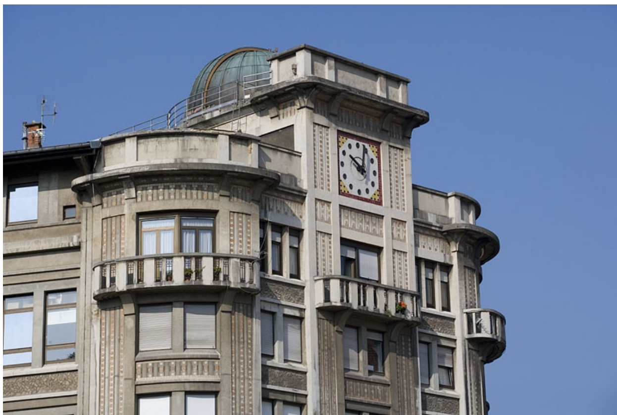
Partie supérieure du corps d'entrée et horloge.
