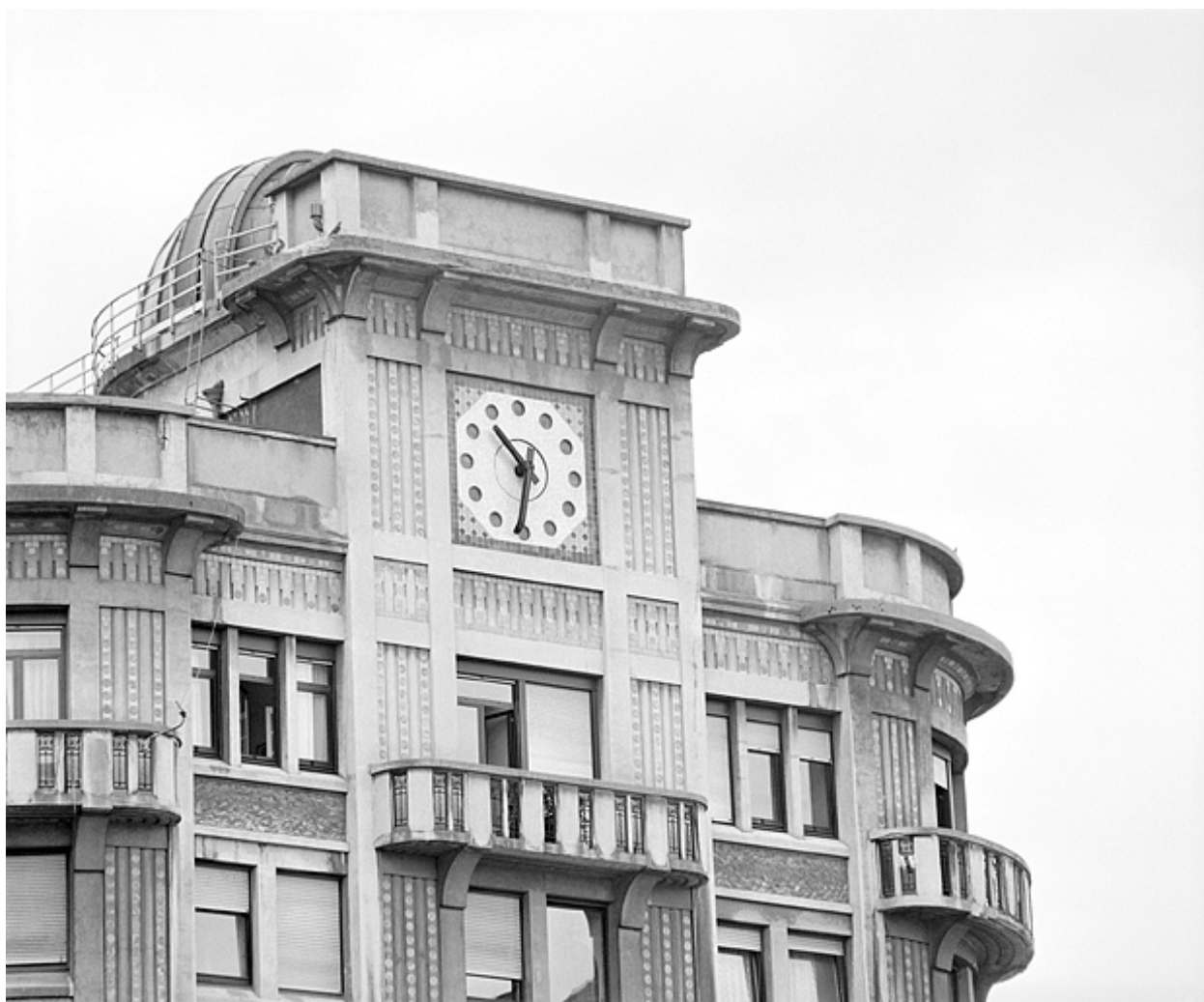
Partie supérieure du corps d'entrée et horloge.
