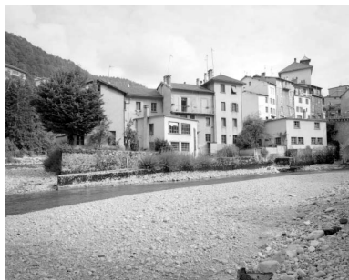
Bâtiments vus du sud. Phot. Jérôme Mongreville IVR43_19923900555X
