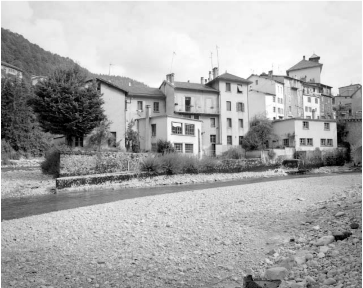
Bâtiments vus du sud.
