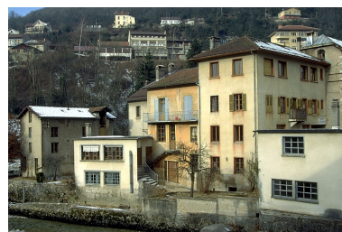
Bâtiments vus de l'est. Phot. Laurent Poupard IVR43_19923901356ZA
