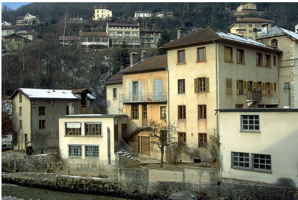
Bâtiments vus de l'est.
