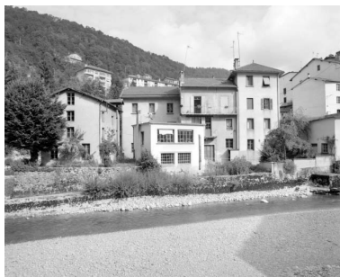
Bâtiments vus du sud-est. Phot. Jérôme Mongreville IVR43_19923900557X
