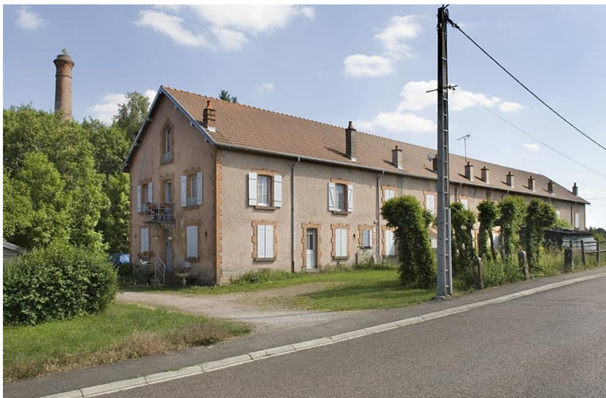
Logement ouvrier dit cité Saint-Anne.
