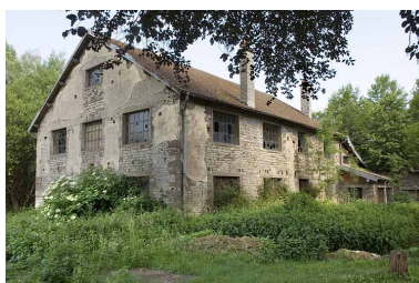
Bureau (?) depuis l'ouest. Phot. Jérôme Mongreville IVR43_20097000457NUC2A
