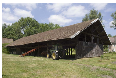
Entrepôt industriel vu depuis le sud. Phot. Jérôme Mongreville IVR43_20097000453NUC2A
