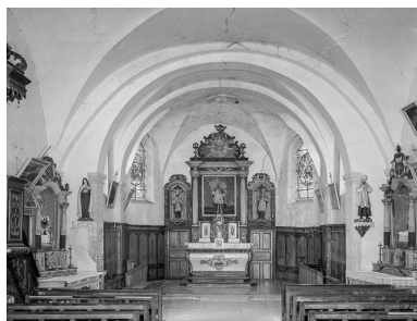
Choeur vu de la nef. Phot. Yves Sancey IVR43_19753900618V
