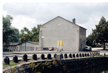
Façade latérale gauche. Phot. Laurent Poupard IVR43_19893900269ZA
