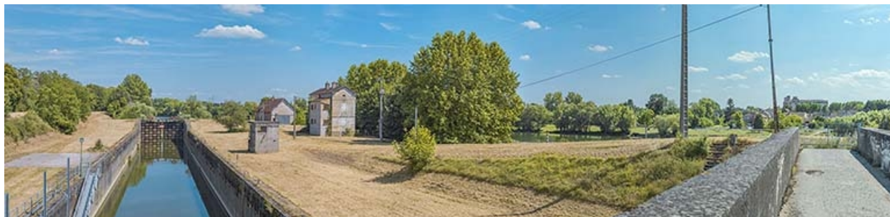
Vue d'ensemble du site d'écluse depuis la passerelle.
