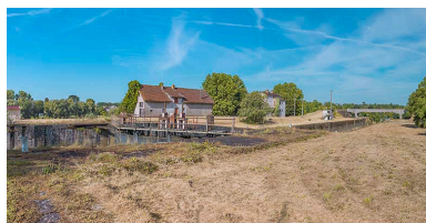
Vue d'ensemble du site d'écluse depuis l'amont. Phot. Thierry Kuntz IVR26_20207100175NUC4A
