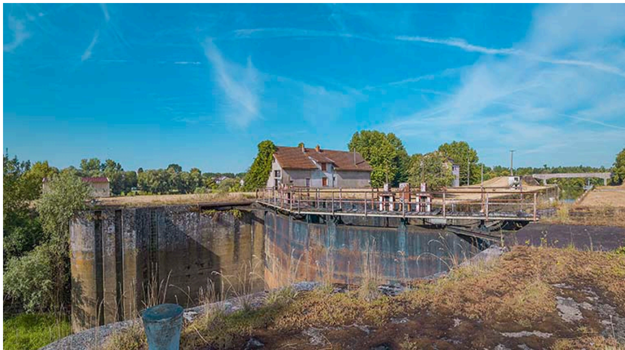
Les portes amont de l'ancienne écluse.
