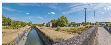
Vue d'ensemble du site d'écluse depuis la passerelle. Phot. Thierry Kuntz IVR26_20207100172NUC4A
