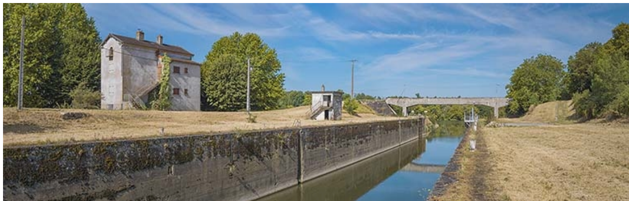
Le sas de l'ancienne écluse.
