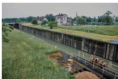
Grande écluse sur la Saône en 2002. Phot. Michel Rosso IVR26_20027100538ZA
