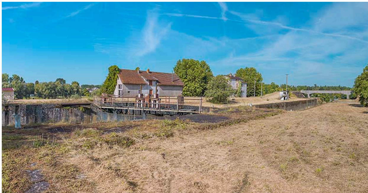
Vue d'ensemble du site d'écluse depuis l'amont.
