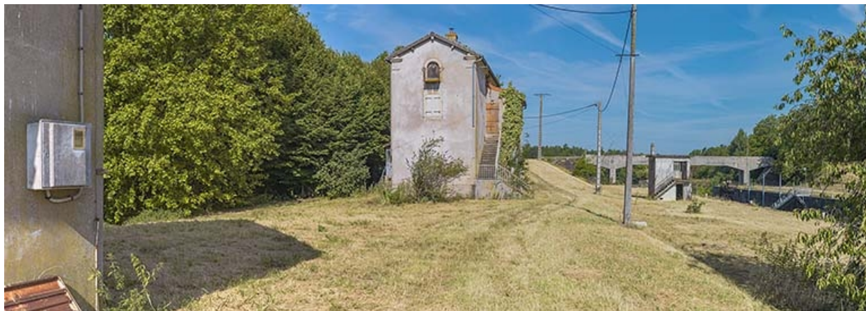
L'ancienne écluse avec au premier plan la maison éclusière et le poste de commande.
