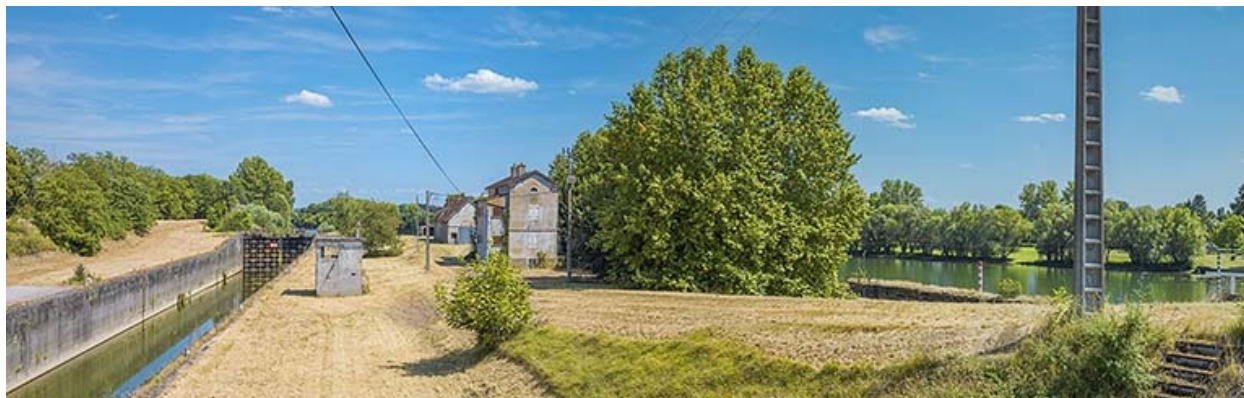
Vue d'ensemble du site d'écluse depuis l'aval.
