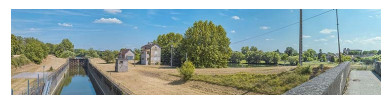
Vue d'ensemble du site d'écluse depuis la passerelle. Phot. Thierry Kuntz IVR26_20207100171NUC4A
