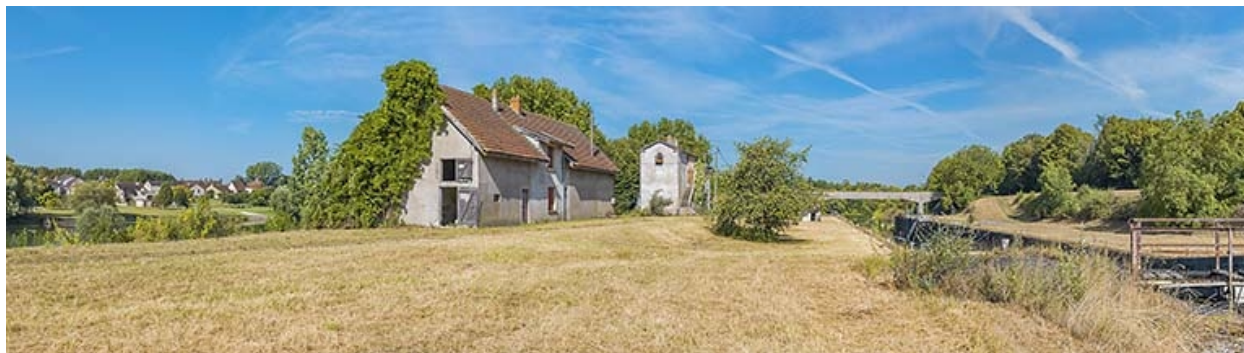
L'ancienne écluse vue depuis l'amont.
