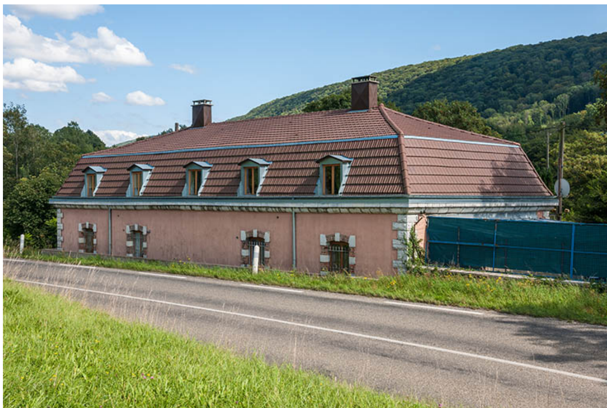
Façade nord du logement.
